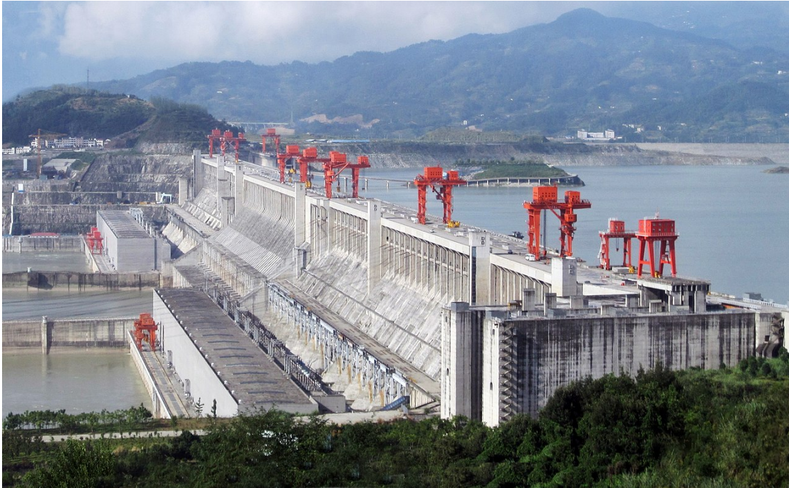
Slika 2.2.2. Pogled na branu hidroelektrane „Tri klanca „[9].
