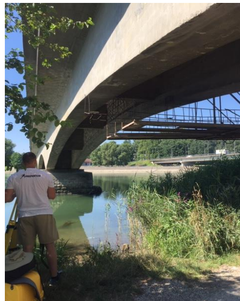
Slika 32. Skeniranje željezničkog mosta
