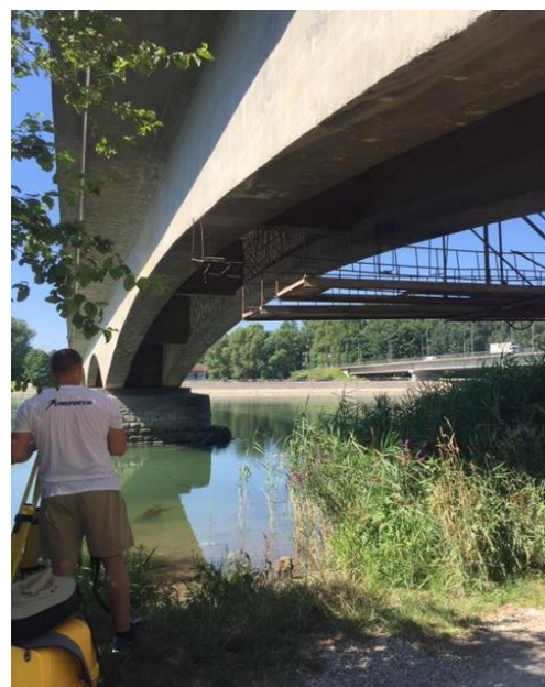
Slika 32. Skeniranje željezničkog mosta
