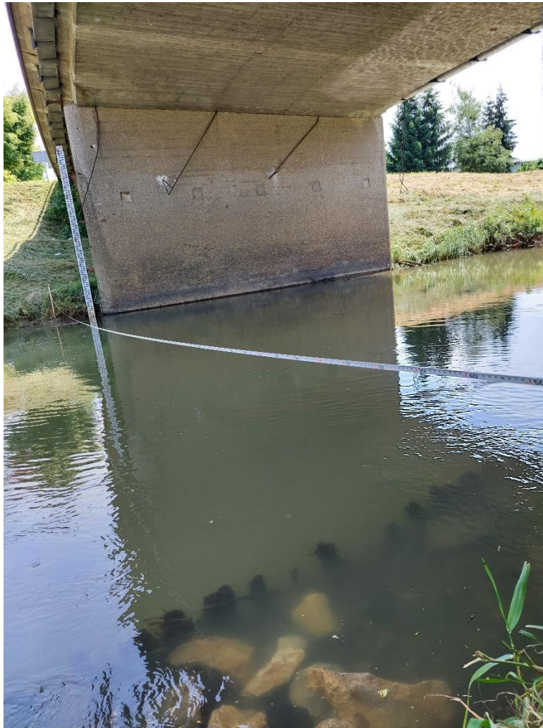
Slika 3.16. Postavljanje mjerne trake
