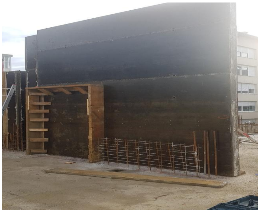
Slika 4.8. Okvirni sustav Doka Framax-osobna arhiva 2020 godine
