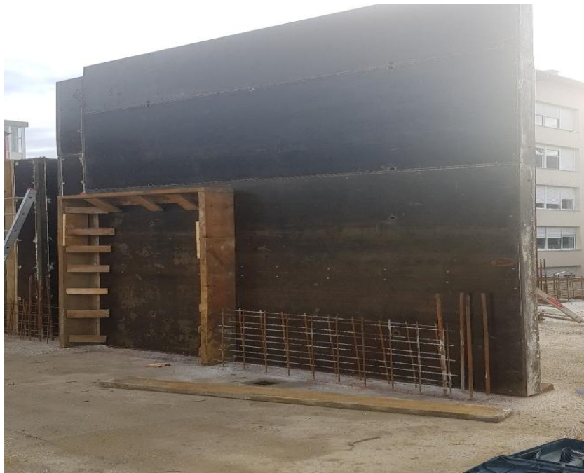
Slika 4.8. Okvirni sustav Doka Framax-osobna arhiva 2020 godine
