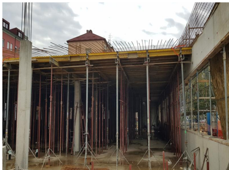
Slika 4.14. Okvirni sustav Doka Dekaflex-izvor sa gradilišta
