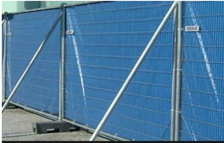
Slika 3.11. Gradilišna ograda
