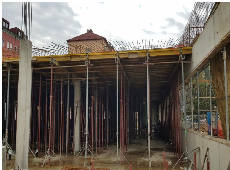
Slika 4.14. Okvirni sustav Doka Dekaflex-izvor sa gradilišta
