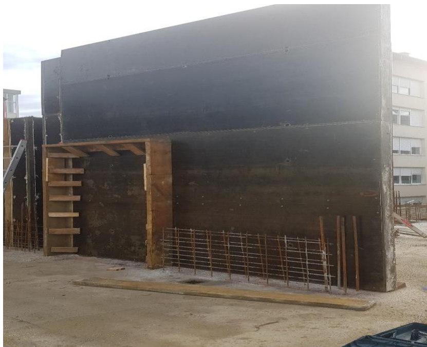
Slika 4.8. Okvirni sustav Doka Framax-osobna arhiva 2020 godine
