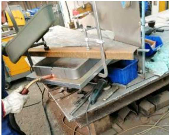
Slika 40. Bravarska montaža postolja
