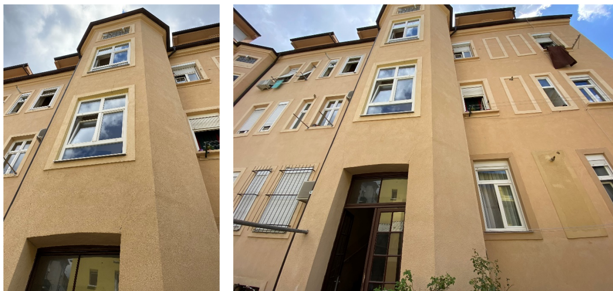
Slika 10. Zapadno pročelje zgrade – ulaz 2a
