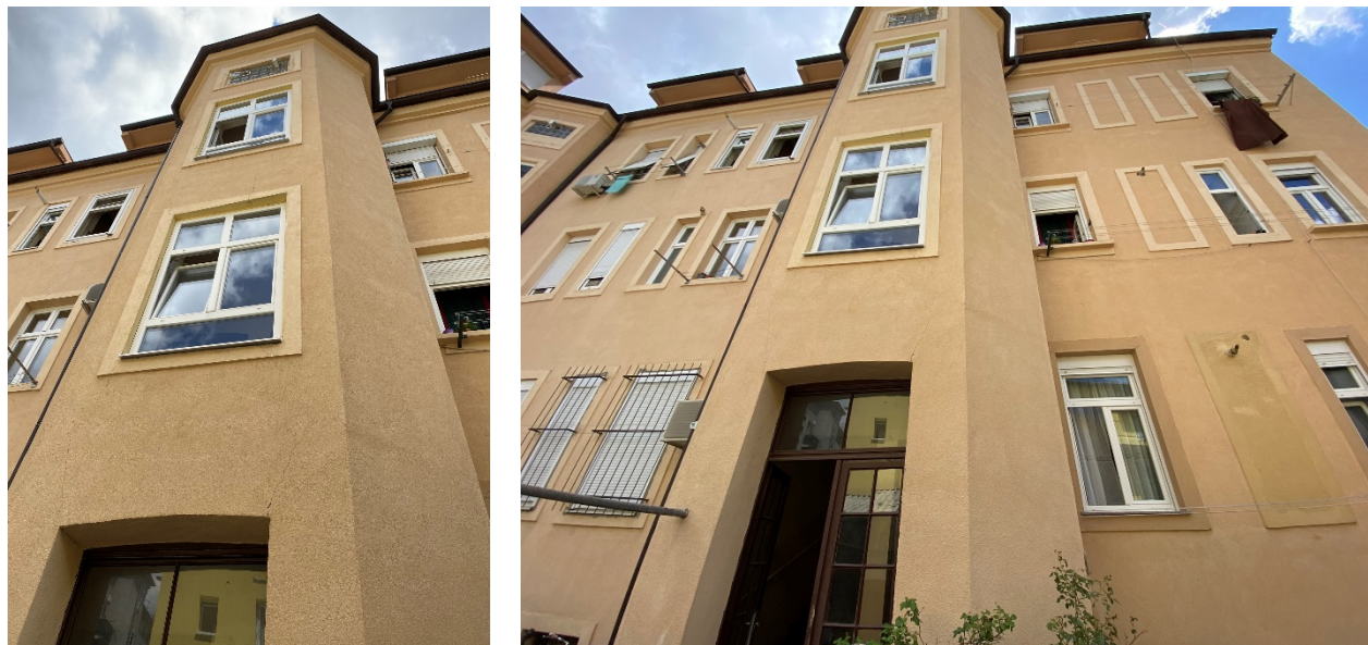
Slika 10. Zapadno pročelje zgrade – ulaz 2a
