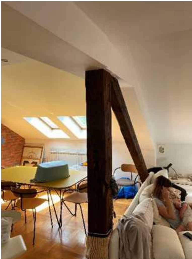
Slika 37. Krovna konstrukcija u potkrovlju stambene zgrade
