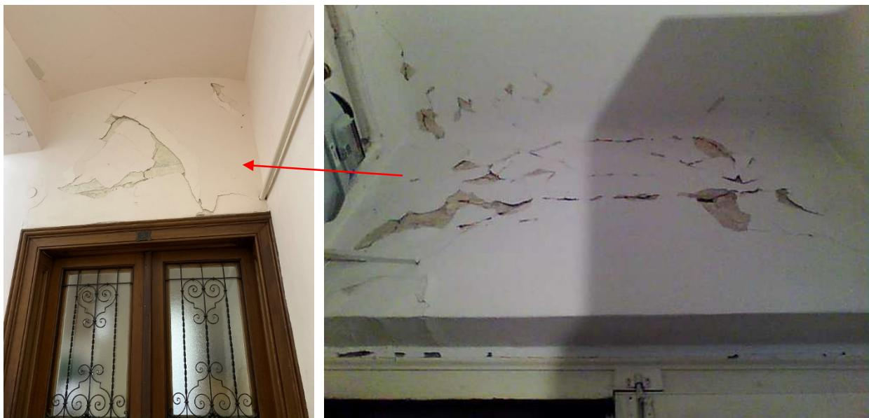
Slika 20. Pukotina s obje strane nosivog zida prema stubištu
