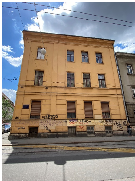
Slika 14. Sjeverno pročelje zgrade koje gleda na Ilicu
