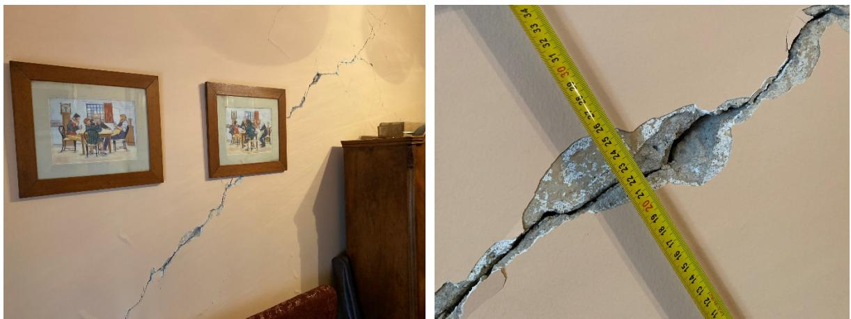
Slika 24. Dijagonalna pukotina južnog nosivog zida stana
