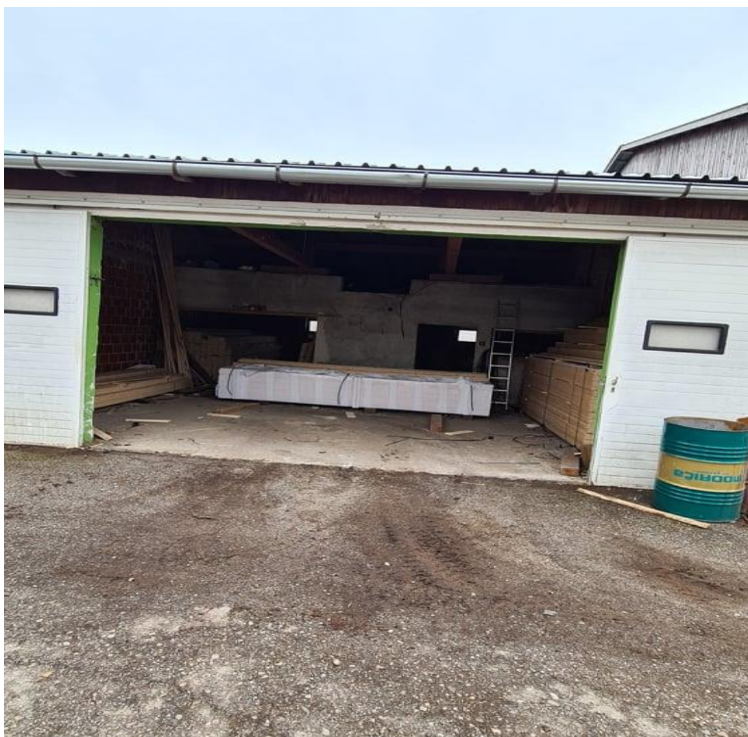
Slika 5. 20 Skladište za gotove proizvode
