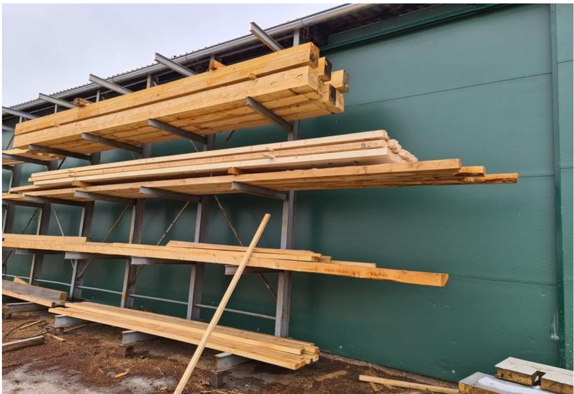
Slika 5. 22 Grede – prirodno sušenje (tretiranje)
