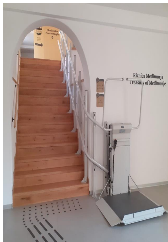
Slika 4.1.5. Prikaz koso postavljene sklopive platforme
