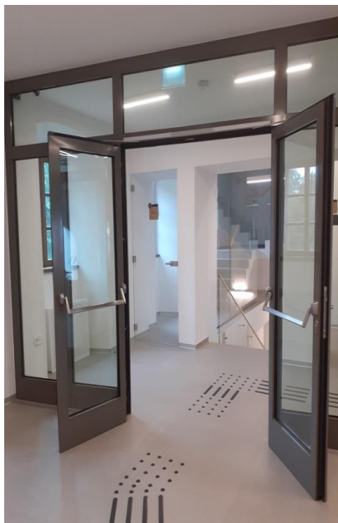
Slika 4.2.1.2. Ulazni prostor unutar objekta
