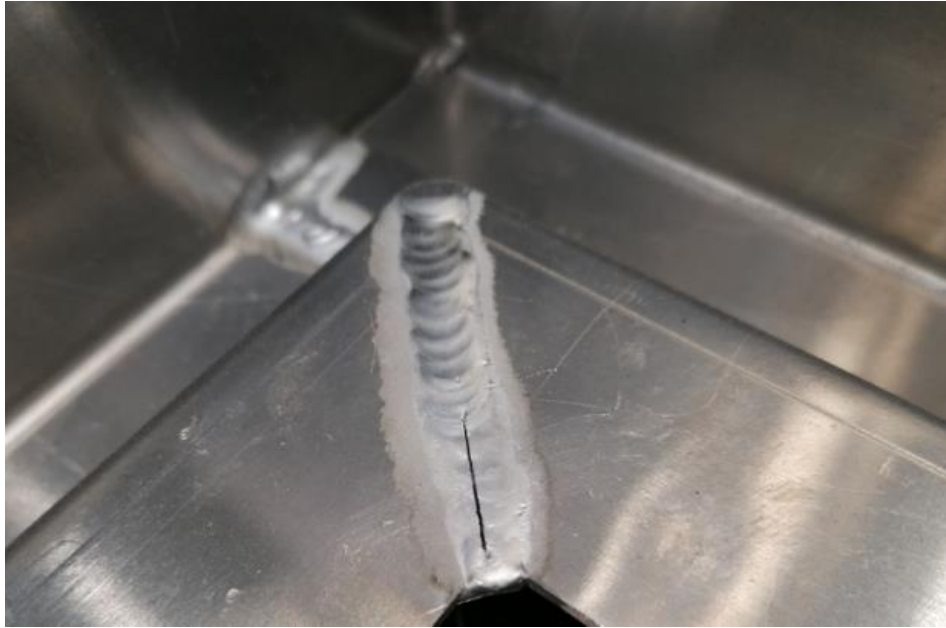
Slika 4.2 Primjer uzdužne pukotine u smjeru zavara
