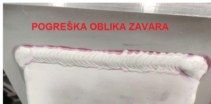
Slika 8.8 Lokalne isprekidane ugorine na zavaru 5HY
