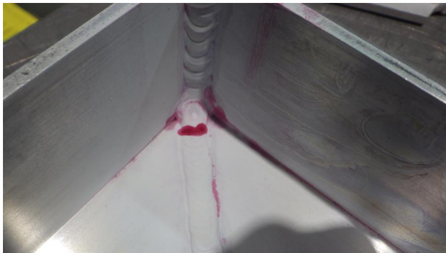
Slika 6.1 PT kontrola zavara
