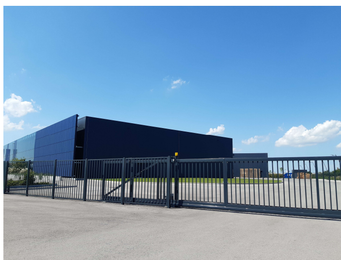
Slika 5.21 Izgled gotovog objekta dilatacija B
