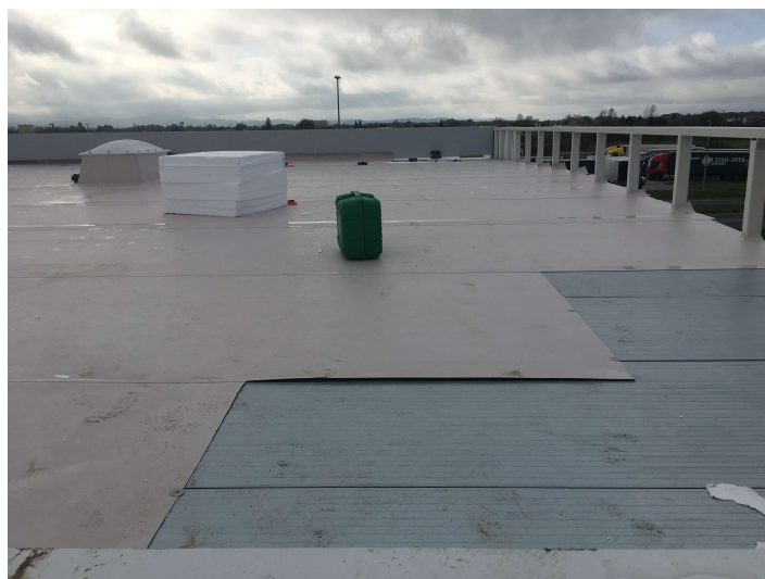
Slika 5.10 Obrada ravnog krova
