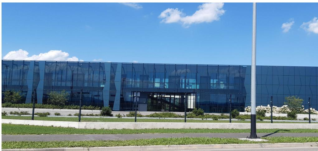
*Slika 5.18 Fotonaponski moduli na fasadi*
