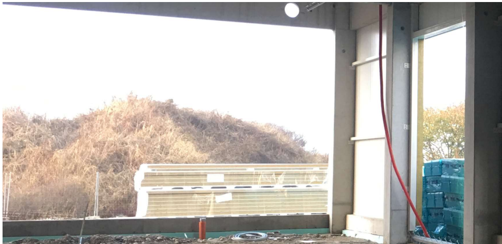
Slika 5.2 Skladištenje materijala na gradilištu
