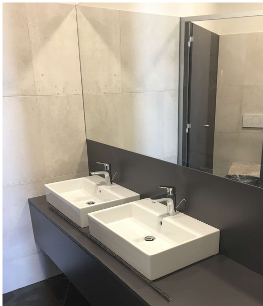
Slika 5.8 Zidovi u sanitarnim čvorovima
