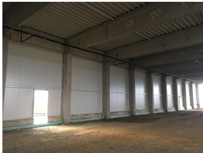
Slika 5.6 Vanjski zidovi od montažnih lakih sendvič panela
