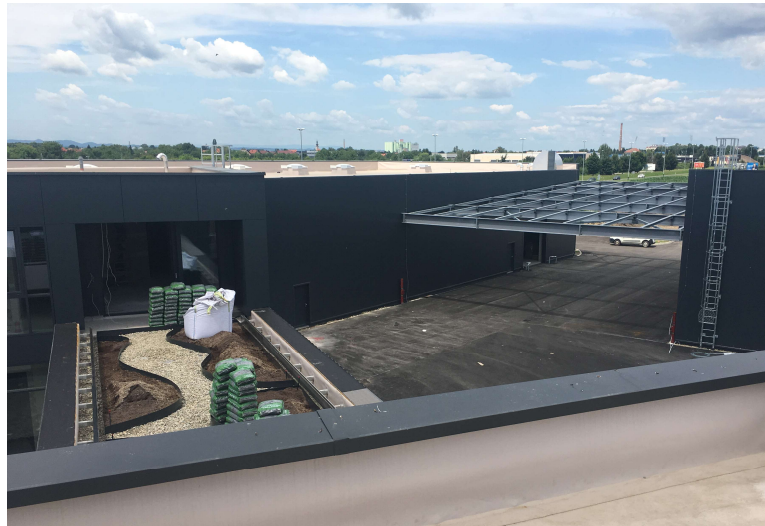
Slika 5.16 Nadstrešnica između dilatacije A i D
