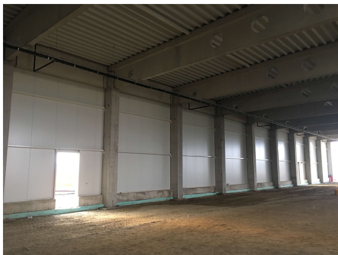
Slika 5.6 Vanjski zidovi od montažnih lakih sendvič panela
