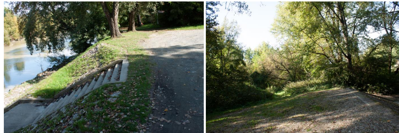
Slika 5.14 Sjeverni nasip na području prirodnog toka rijeke Drave, obložen s kamenom, u nastavku staza prema odredištu „Plaža“, pogled prema istoku (nizvodno). Autor: M.K. Datum: 09.10.2020.
