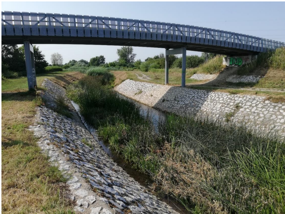
Slika 1.4. Primjer obaloutvrde na rijeci Plitvici kod Varaždina [3]
