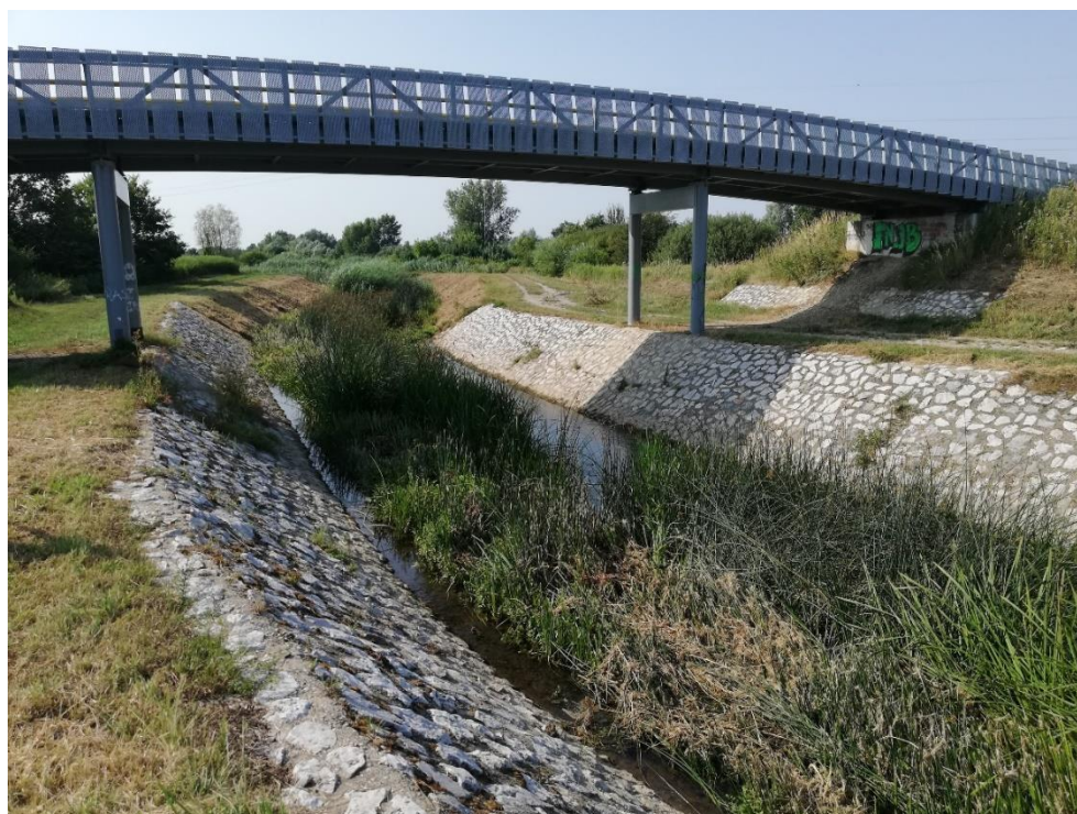
Slika 1.4. Primjer obaloutvrde na rijeci Plitvici kod Varaždina [3]
