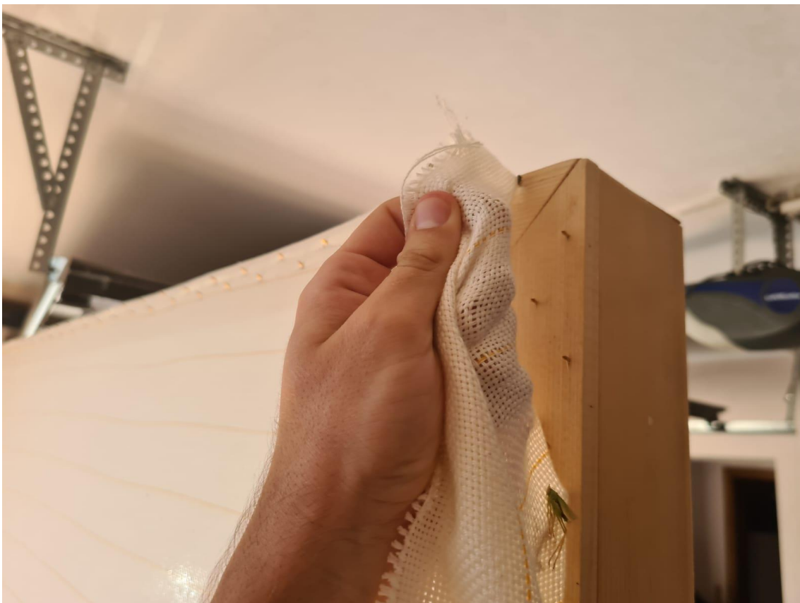
Slika 25. Vizualni prikaz stavljanja platna na okvir
