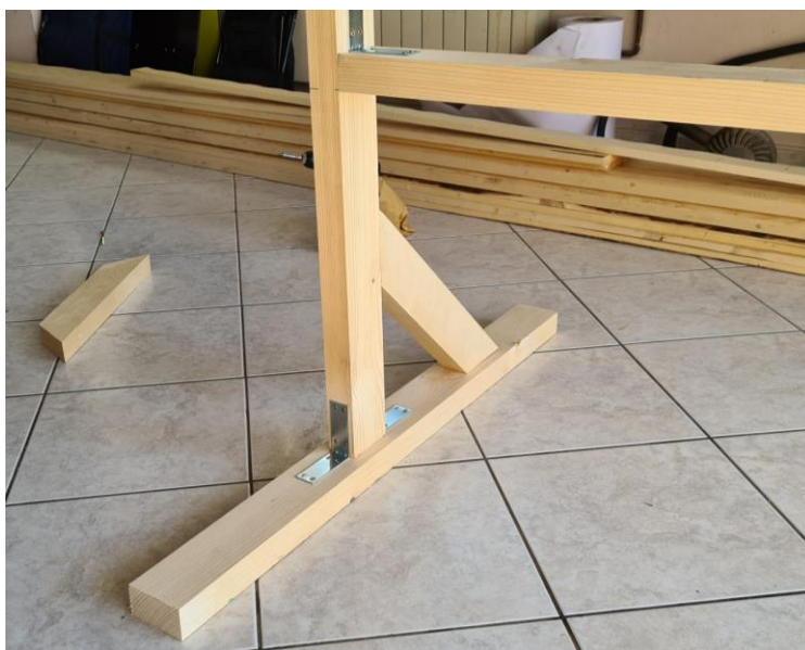
Slika 12. Vizualni prikaz potpore nogama okvira
