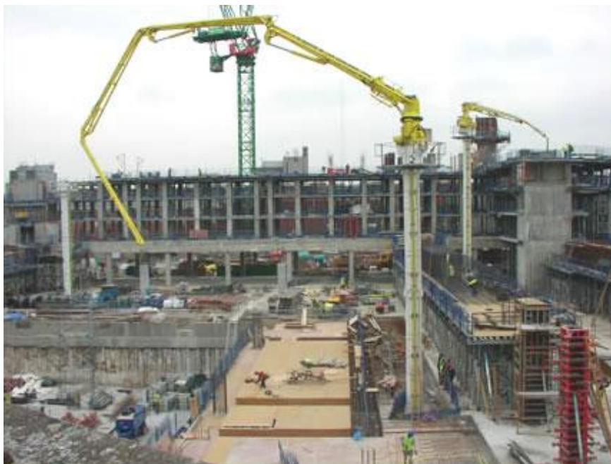
Slika 5.1 Sustav za transport betona [19]
