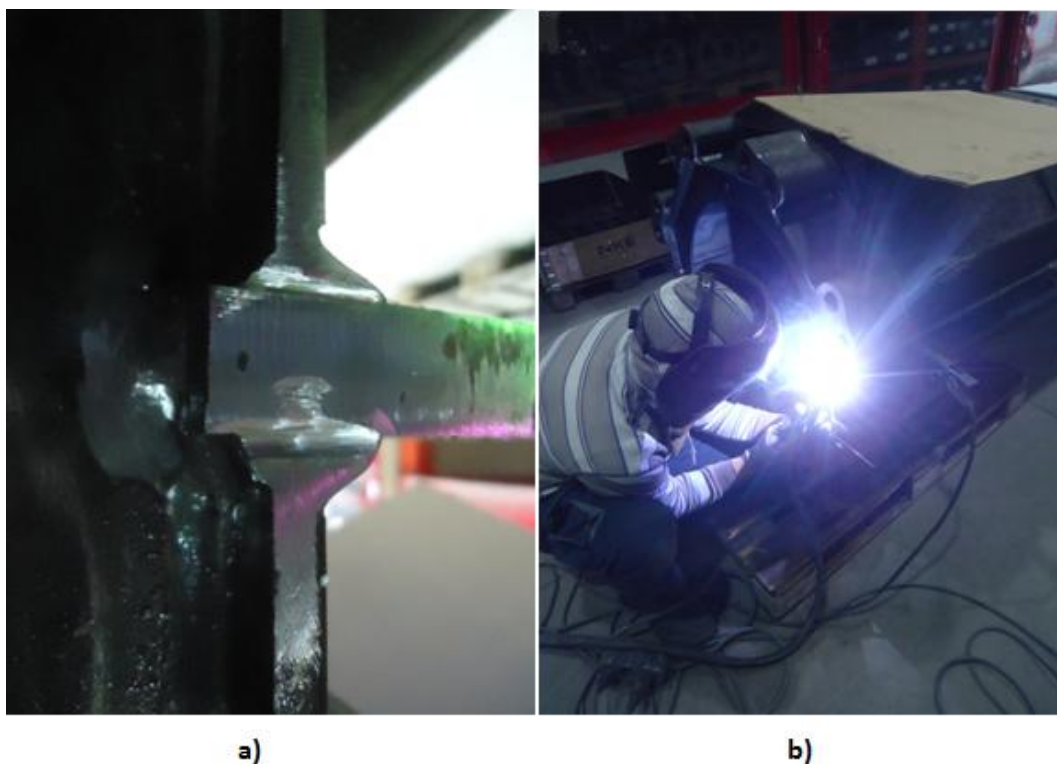
Slika 5.21 Prikaz brušene površine (a) i navarivanja TIG postupkom (b)
