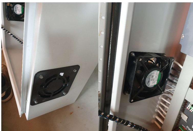
Slika 4.10 Montiranje ventilatora i zaštite
