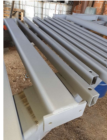
Slika 3.39 Premaz temeljnom bojom
