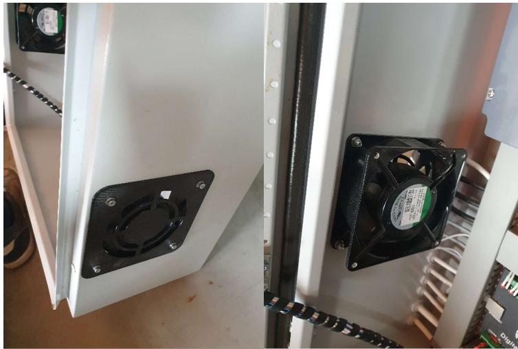
Slika 4.10 Montiranje ventilatora i zaštite
