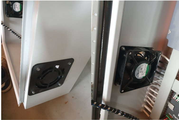
Slika 4.10 Montiranje ventilatora i zaštite
