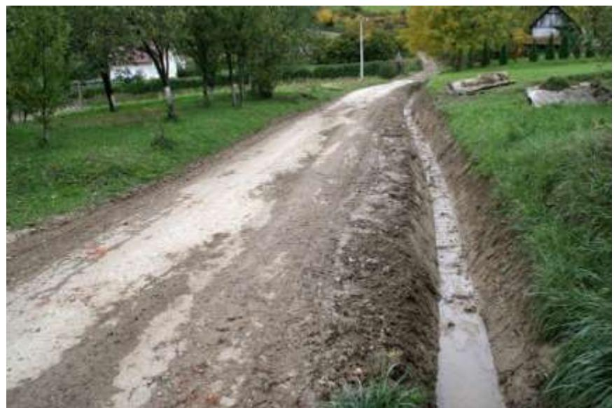
*Slika 2.1.3. Odvodni jarak bez obloge (uzdužni nagibi od 0,2-2,0%)*
