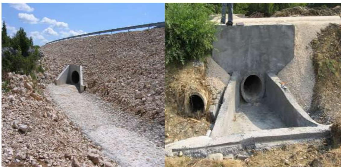
*Slika 4.1.1.4 Cijevni propusti u praksi*
