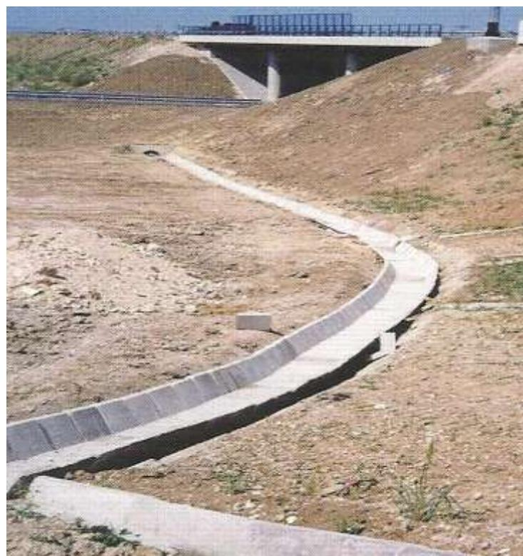
Slika 2.2.4. Zaštitni jarak uz nožicu nasipa od predgotovljenih elemenata
