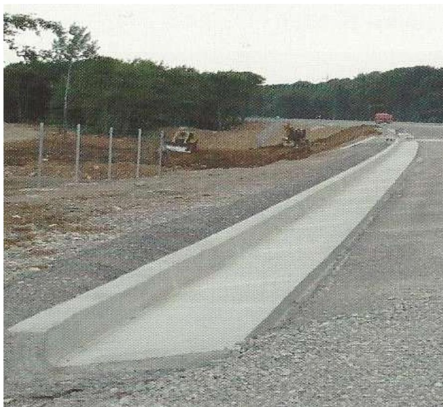
*Slika 2.3.4. Betonski trokutasti rigol izveden kontinuirano*
