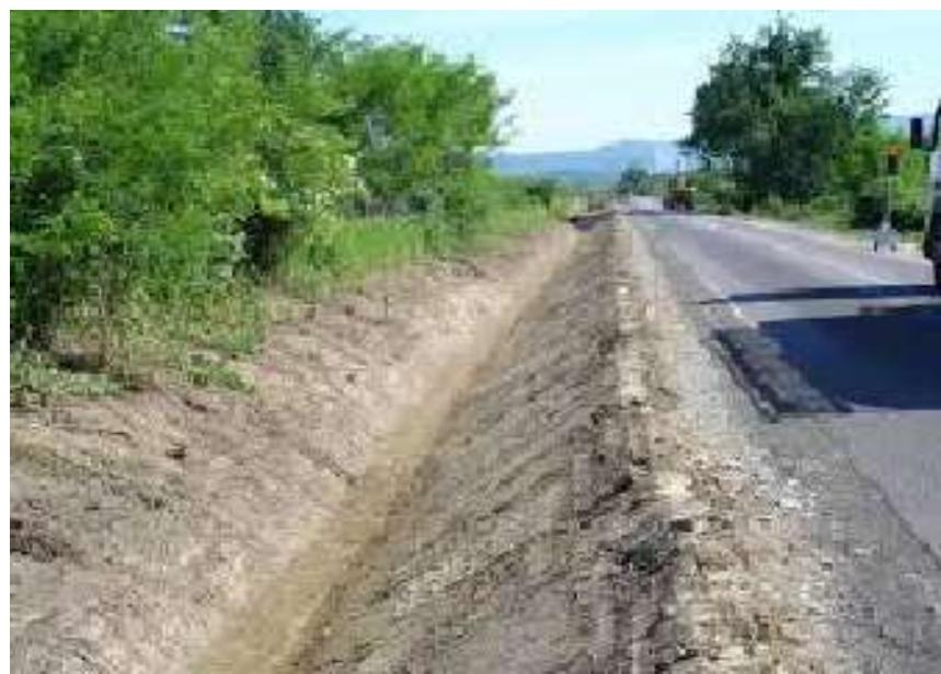
*Slika 2.1.3.a) Odvodni jarak (trapezni)*
