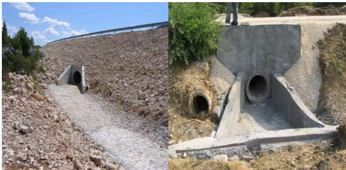
Slika 4.1.1.4 Cijevni propusti u praksi
