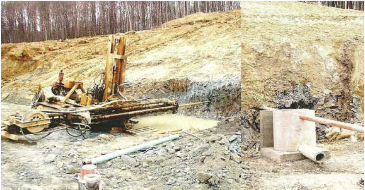
Slika 3.4.1 Bušenje horizontalne drenaže s detaljem spoja na odvodnju
