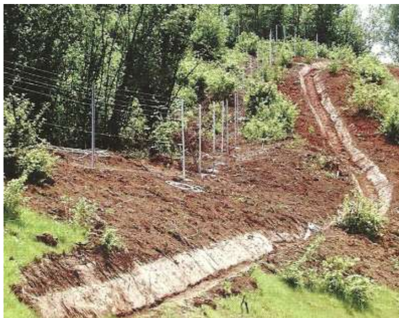
Slika 2.2.2. Zaštitni jarak u praksi
