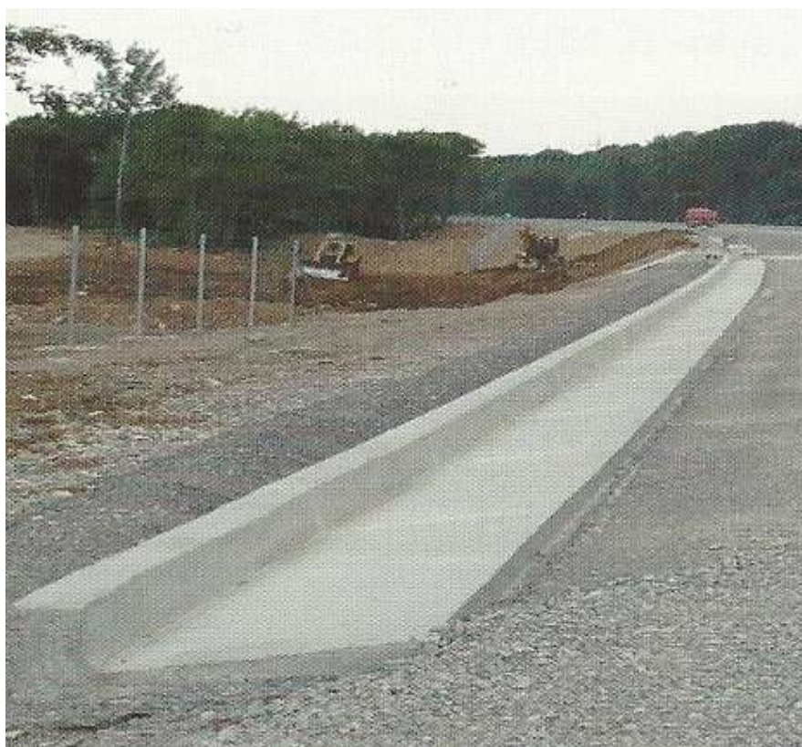
Slika 2.3.4. Betonski trokutasti rigol izveden kontinuirano
