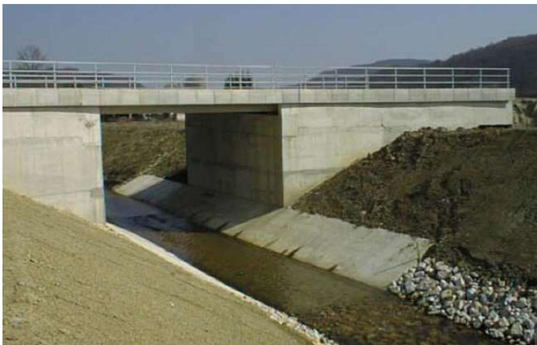
*Slika 4.1.3.3. Gotovi pločasti propust u praksi*
