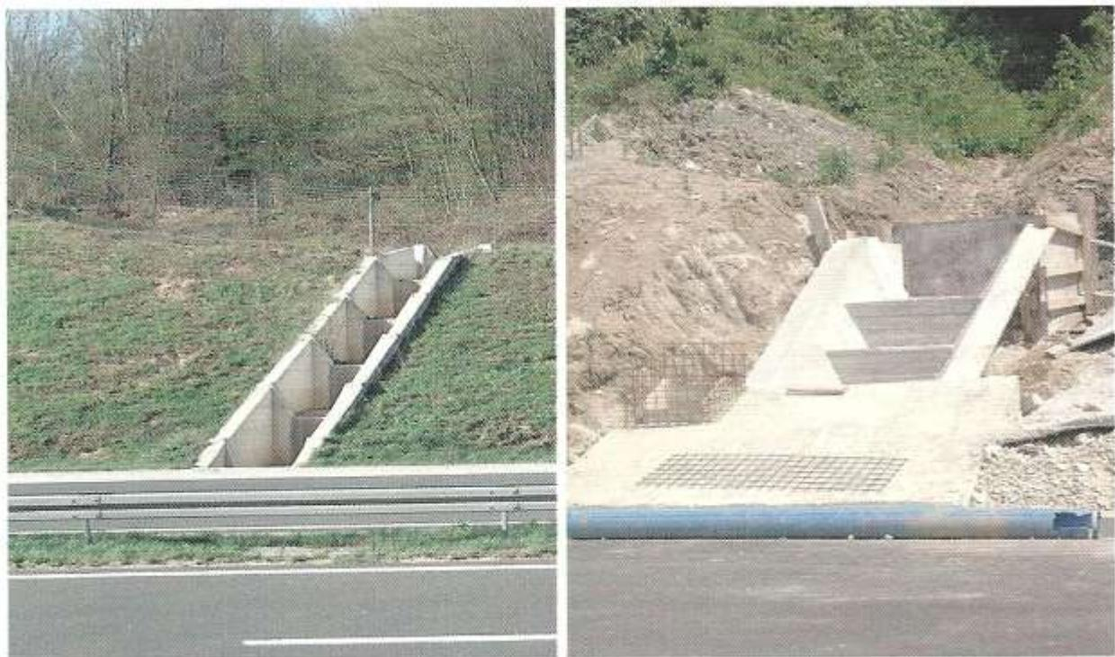
Slika 4.2.2 Kaskade na uljevu u propust
