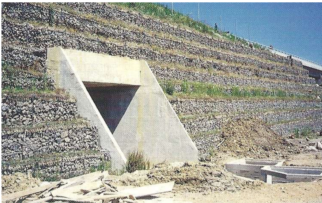
Slika 4.2.4 Izljevna glava propusta u praksi
