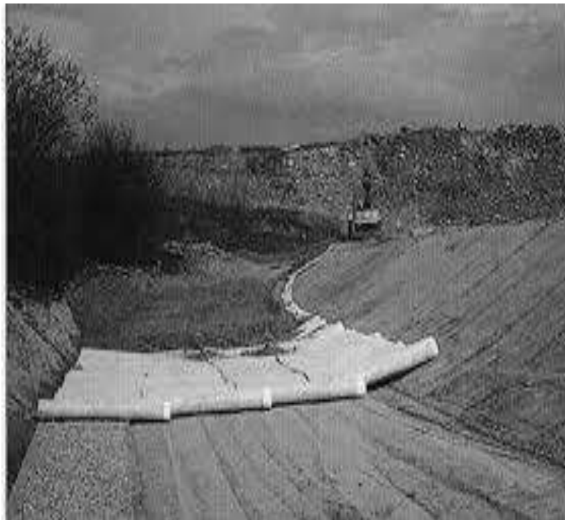
Slika 3.1.3. Primjer polaganja geotekstila u praksi
