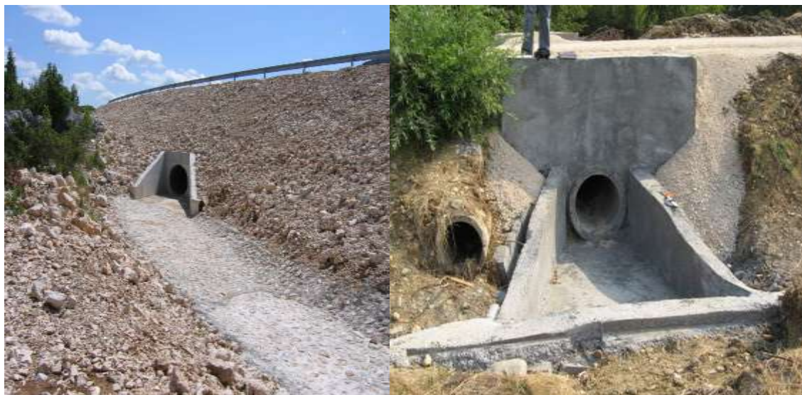
Slika 4.1.1.4 Cijevni propusti u praksi
