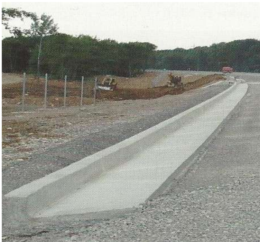
Slika 2.3.4. Betonski trokutasti rigol izveden kontinuirano
