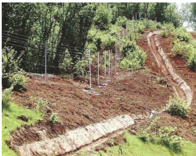
Slika 2.2.2. Zaštitni jarak u praksi
