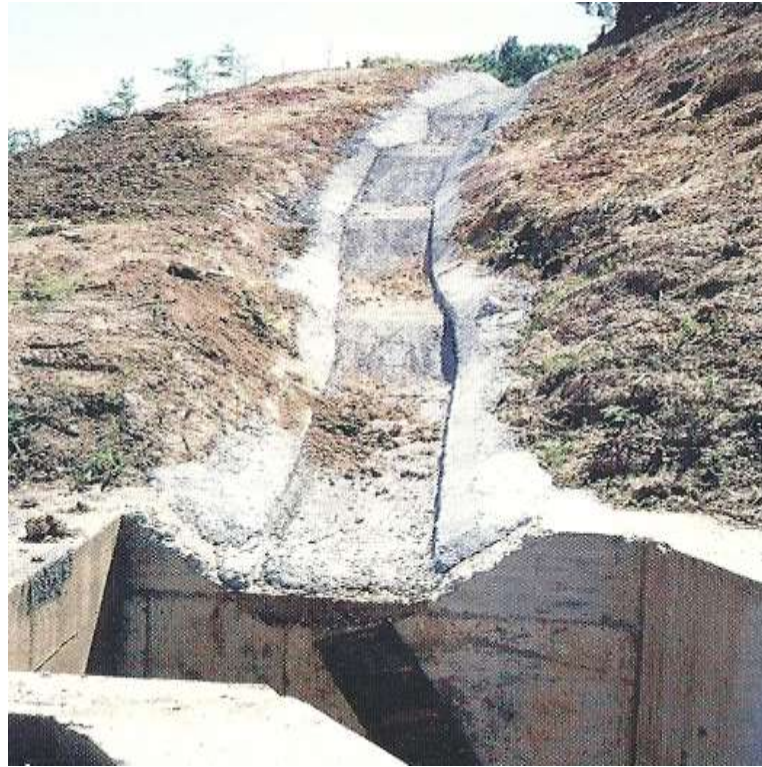
Slika 2.1.7. Kaskadni odvodni jarak
