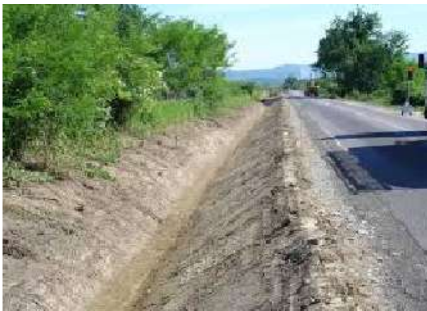
Slika 2.1.3.a) Odvodni jarak (trapezni)
