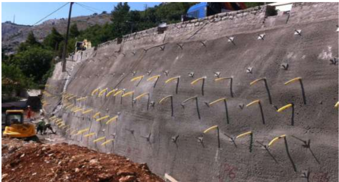
Slika 3.4.2 Stabilizacija pokosa sidrima i drenažom
