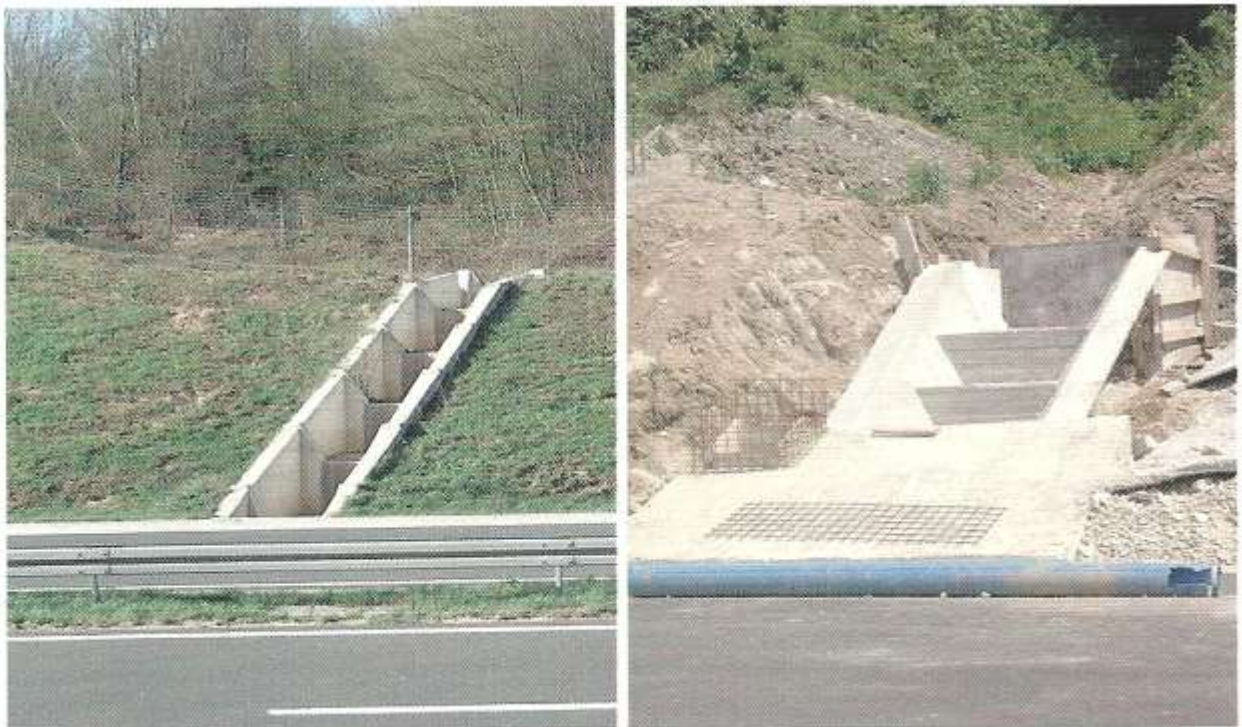
Slika 4.2.2 Kaskade na uljevu u propust
