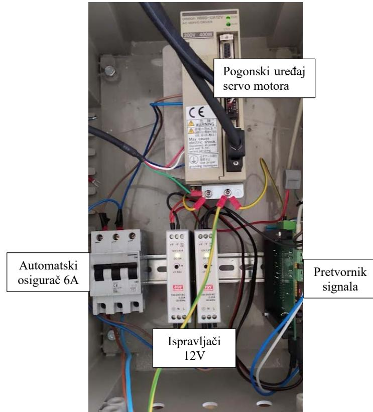
Slika 29. Pretvornik montiran u elektroormaru
