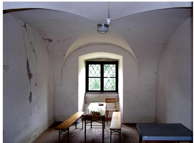
Slika 3.7 Fotodokumentacija zatečenog stanja zidova
