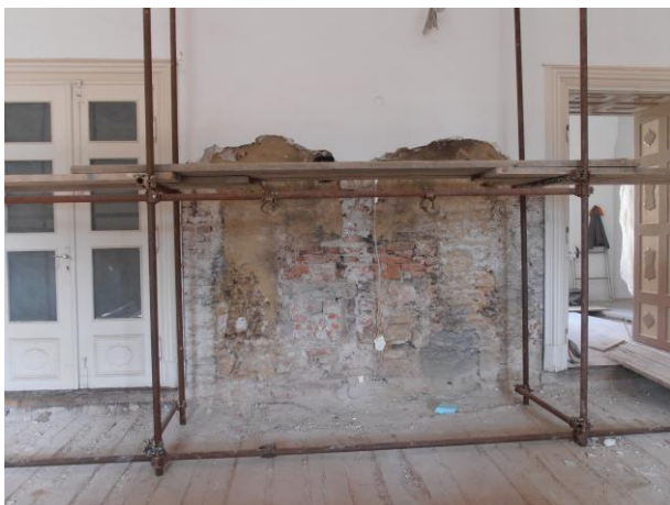
Slika 3.25 Fotodokumentacija oštećenja od vlage
