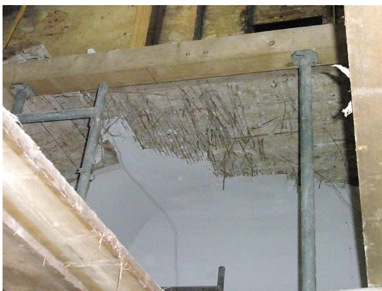
Slika 3.9 Međukatna konstrukcija drvenog grednika
