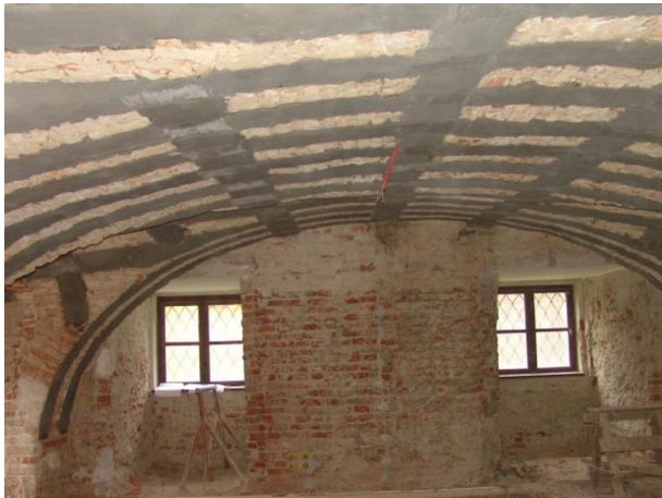
Slika 5.22 Prikaz ugrađivanja karbonskih traka
