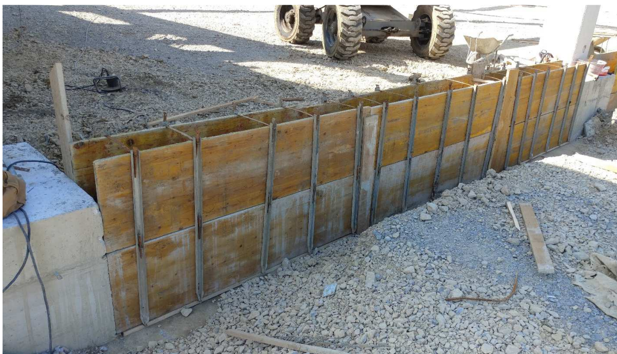
Slika 4 Prikaz postavljanja oplata limenim U profilima i odstoynicima
