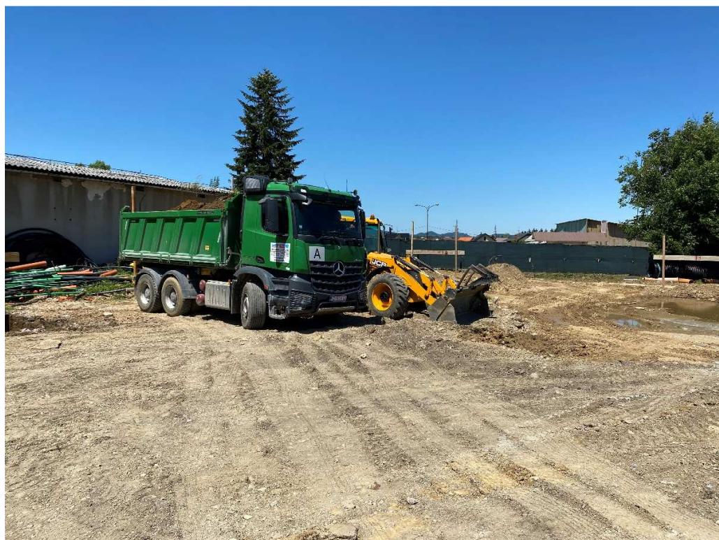
Slika 2 Prikaz utovara zemljjanog materijala za odvoz
