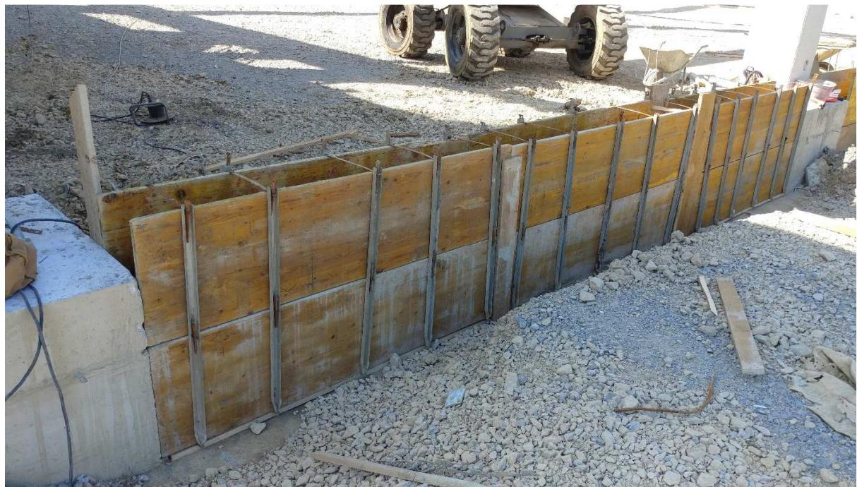
Slika 4 Prikaz postavljanja oplate limenim U profilima i odstojnicima
