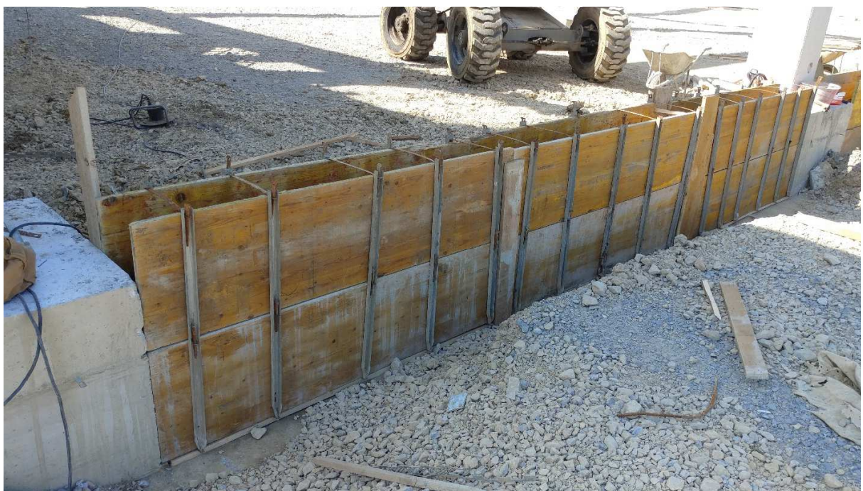
Slika 4 Prikaz postavljanja oplata limenim U profilima i odstojnicima
