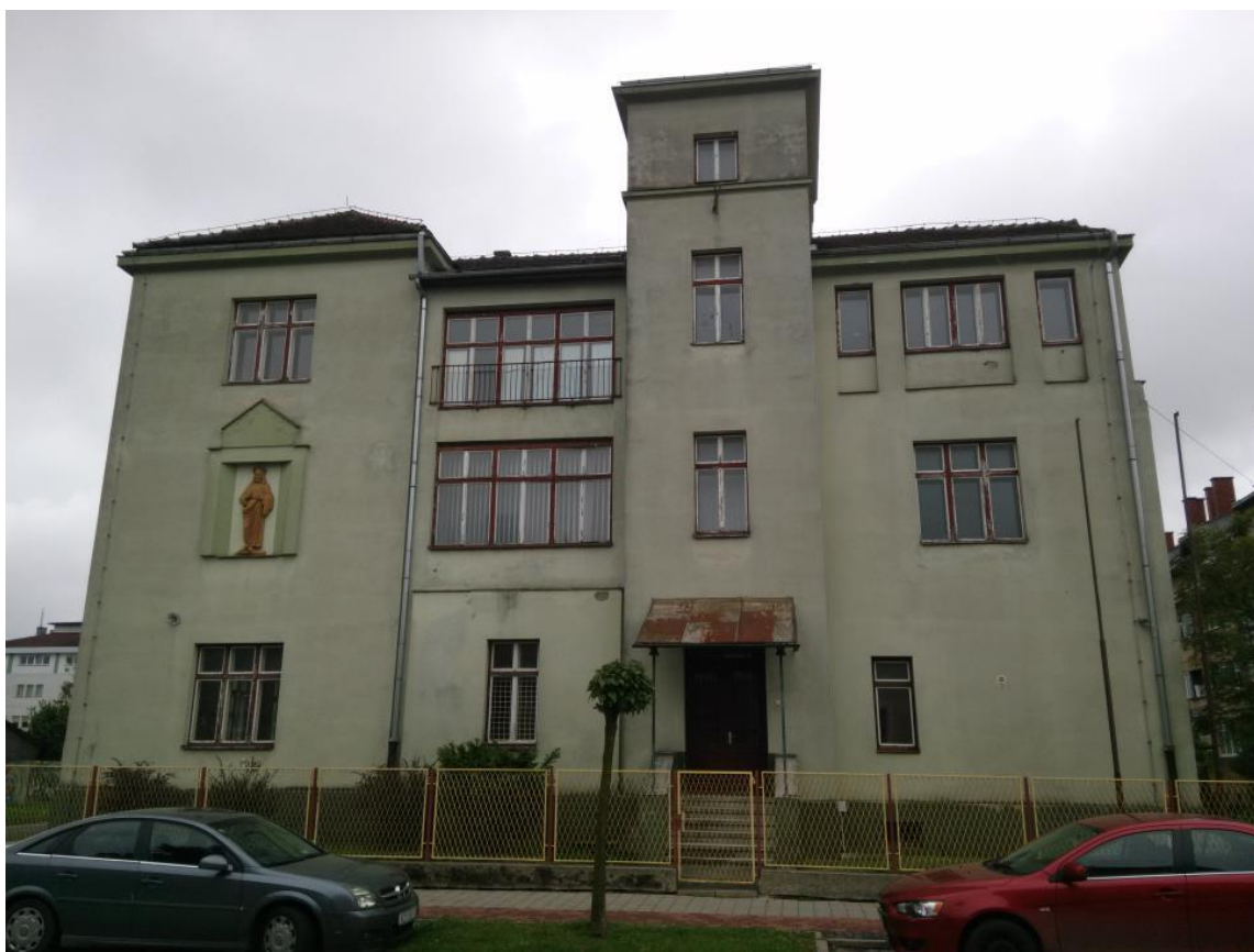
Slika 5.3 Pogled na sjevero-zapadno pročelje predmetne zgrade
