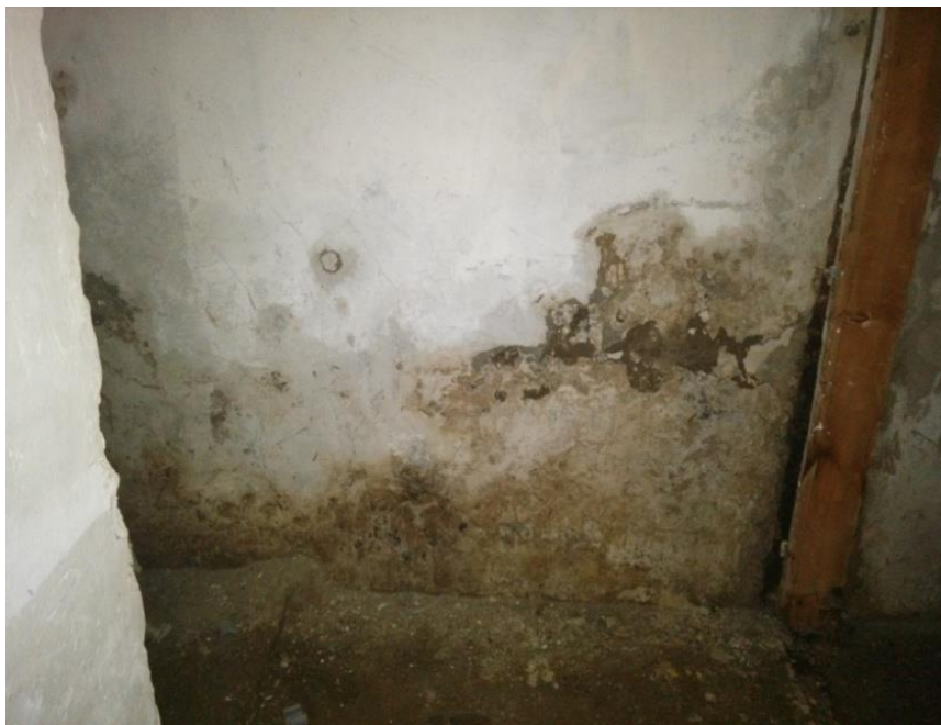
Slika 5.5 Učinci kapilarne vlage u podrumskim zidovima
