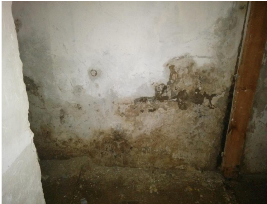
Slika 5.5 Učinci kapilarne vlage u podrumskim zidovima
