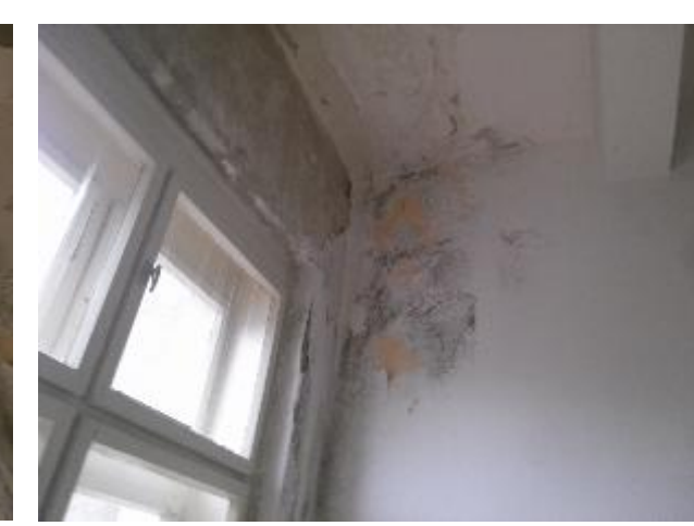
B. Pojava plijesni na zidu
