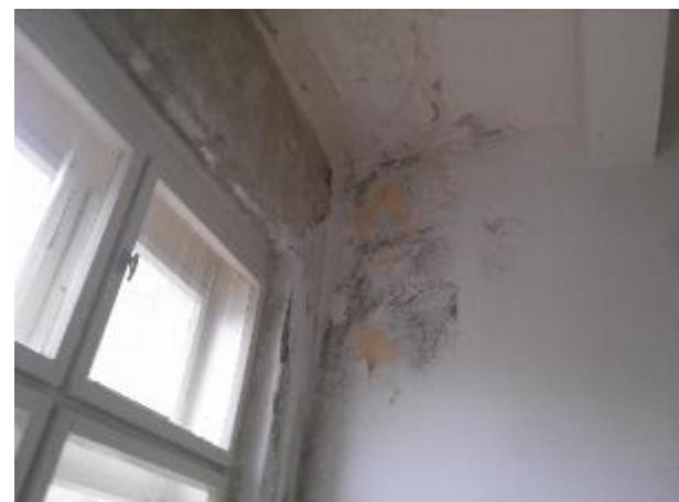
B. Pojava plijesni na zidu
