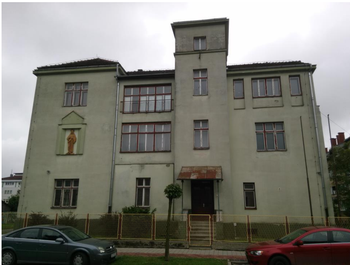
Slika 5.3 Pogled na sjevero-zapadno pročelje predmetne zgrade
