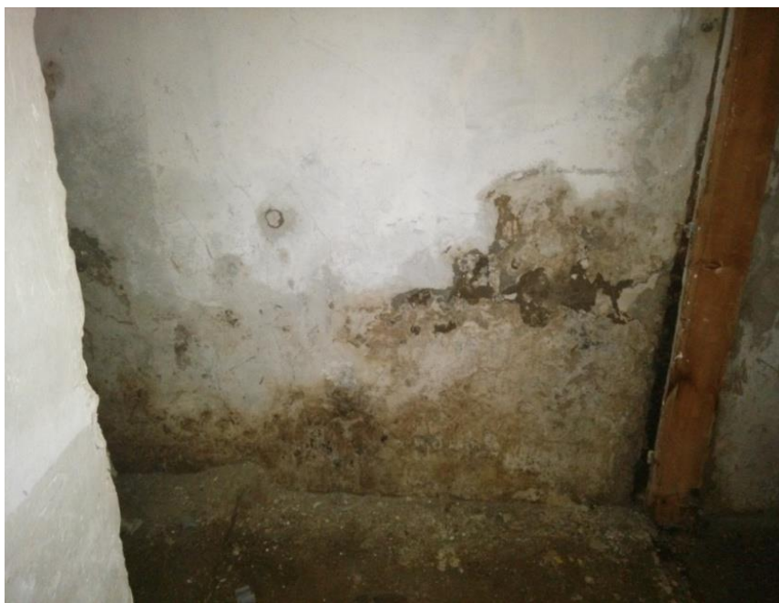
Slika 5.5 Učinci kapilarne vlage u podrumskim zidovima
