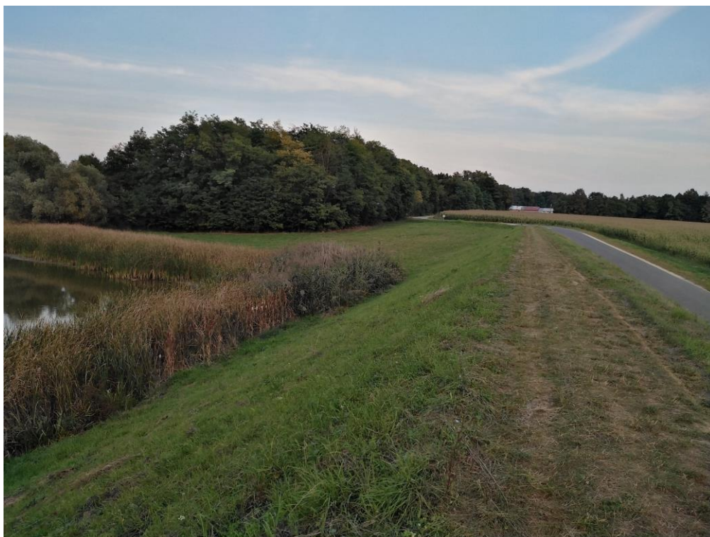
Slika 26. Uređenje šetnice na nasipu [18]
