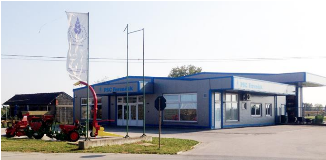
Slika 6. Poslovnica u Bjelovaru
