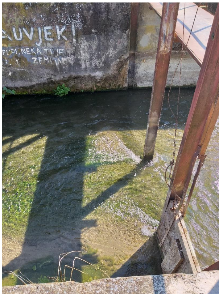
Slika 5.1. Poremećaji toka zbog prepreka
