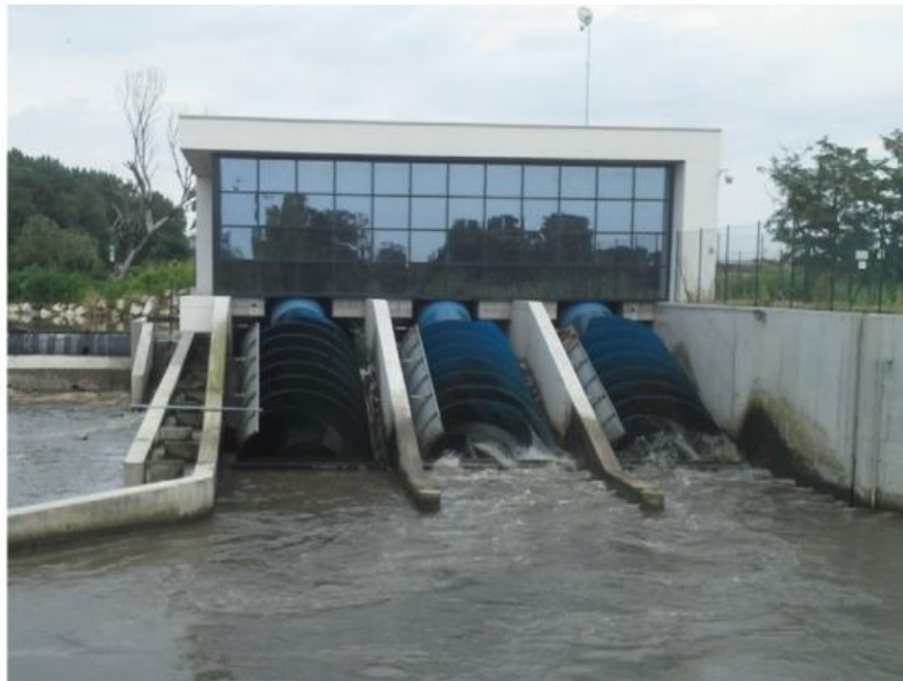
Slika 3.1. Tri paralelna Arhimedova vijka [10]
