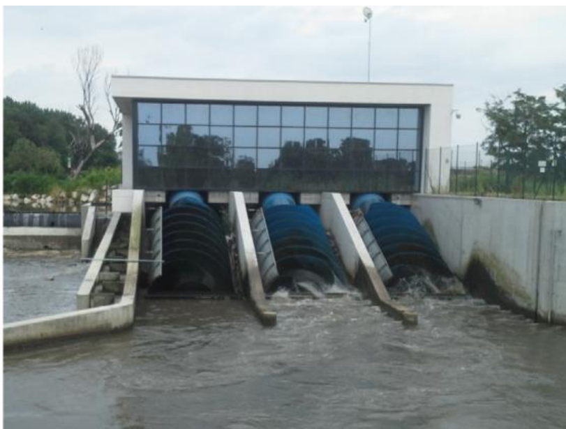
Slika 3.1. Tri paralelna Arhimedova vijka [10]
