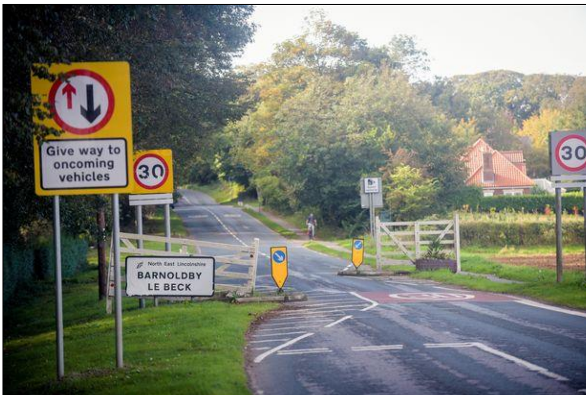
Slika 5.15. Ulazni infrastrukturni tretman za novi režim brzine
