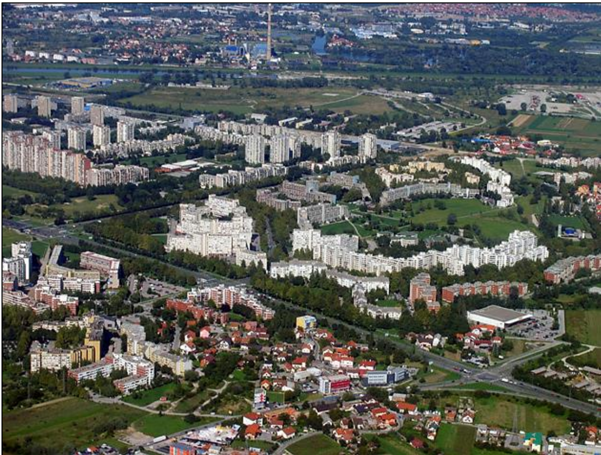
Slika 4.1. Pogled iz zraka na urbano naselje Dugave
