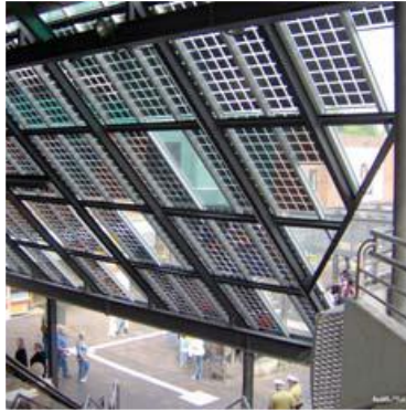
Slika 7. Ugradnja na krov. Izvor: [9]
