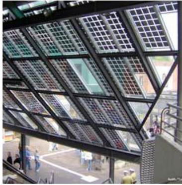
Slika 7. Ugradnja na krov. Izvor: [9]
