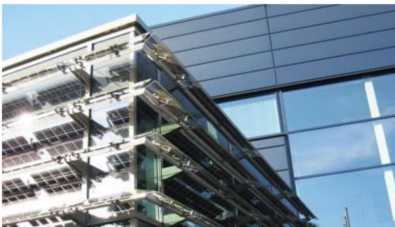
Slika 9. Ugradnja na prozore. Izvor: [9]
