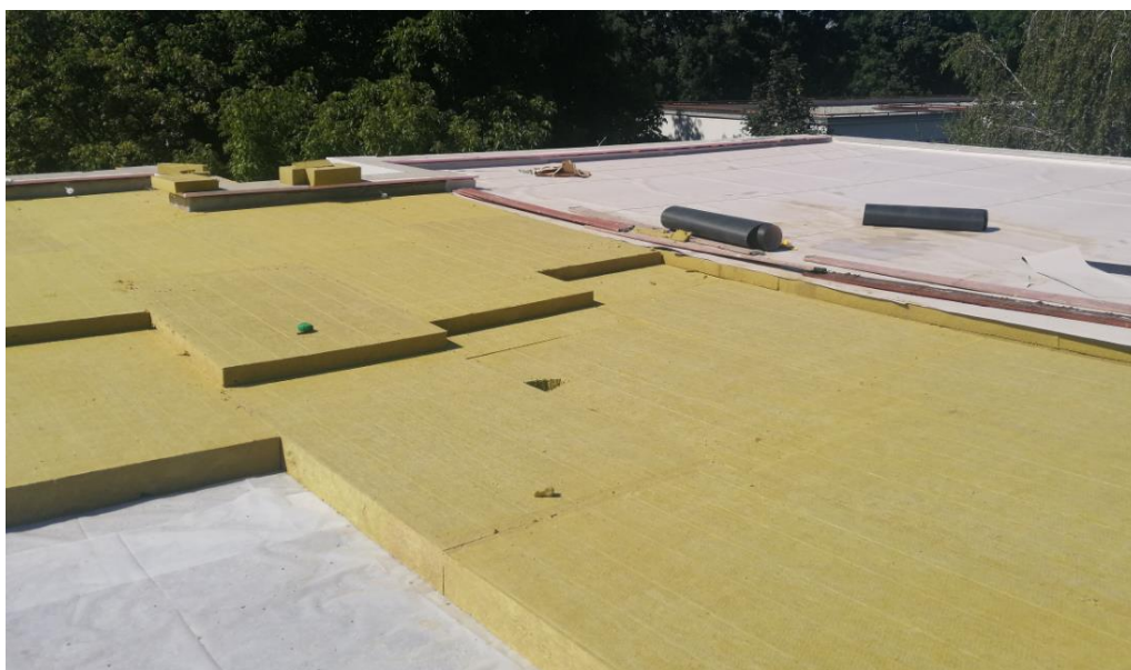
Slika 23. Toplinska izolacija krova [10]
