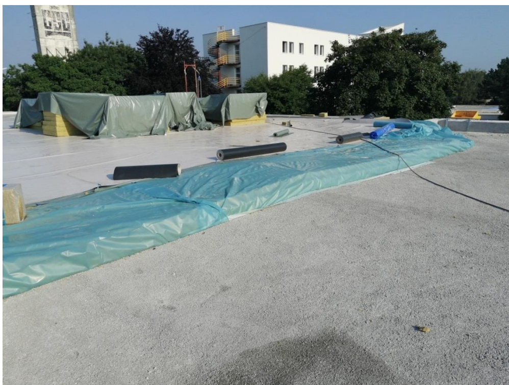
Slika 24. Izvođenje završnog sloja krova od TPO folije [10]
