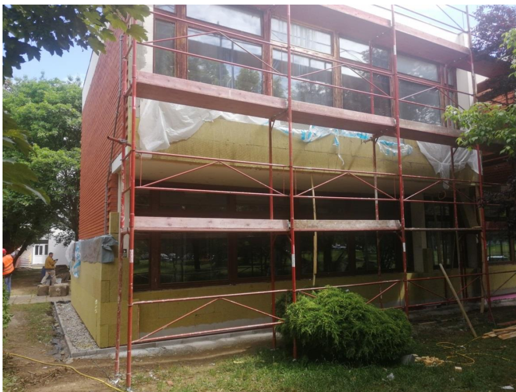
Slika 18. Toplinska izolacija južnog pročelja
