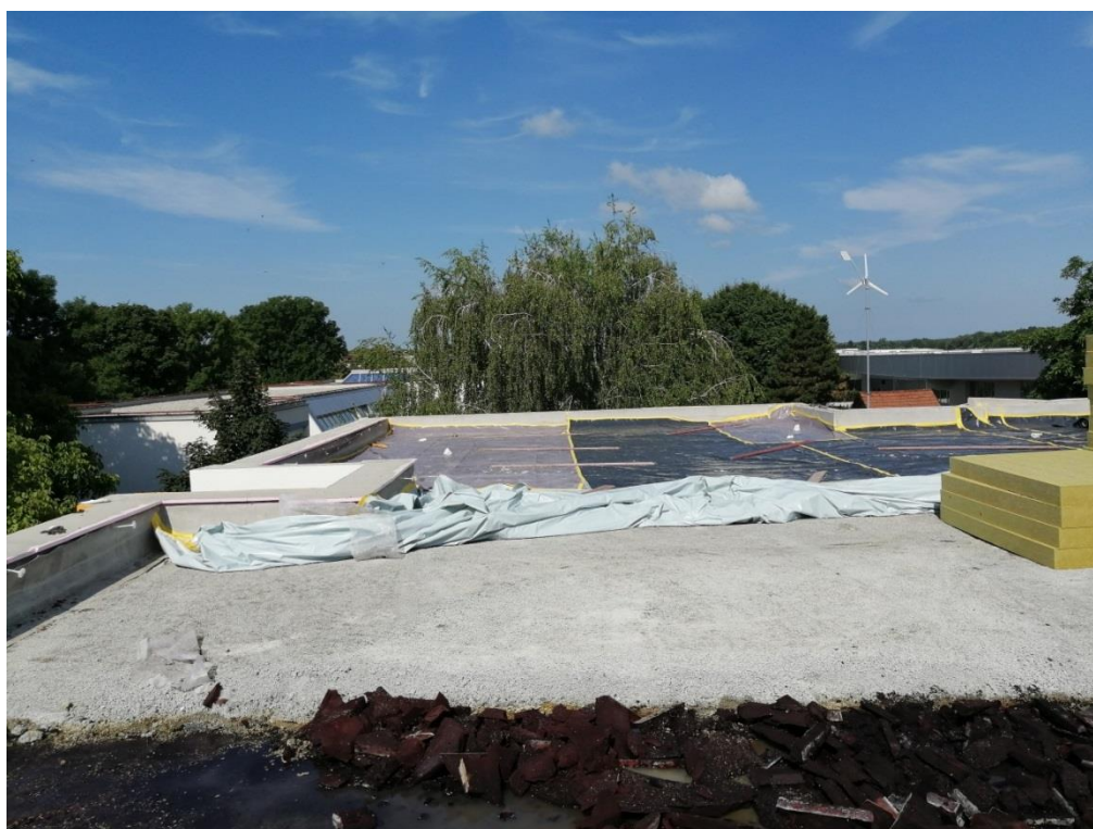
Slika 22. Izvođenje radova na krovu škole [10]
