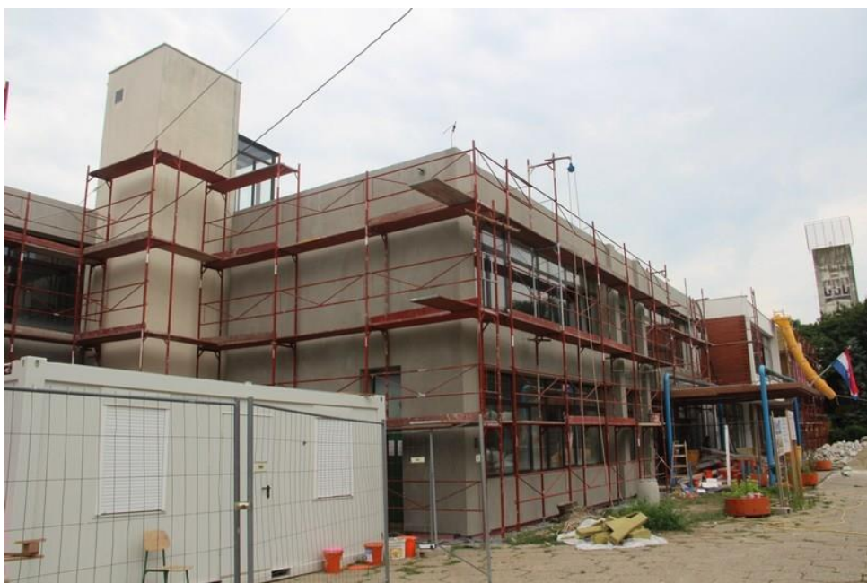
Slika 20. Implementacija polimer-cementnog ljepila armiranog tekstilno-staklenom mrežicom
