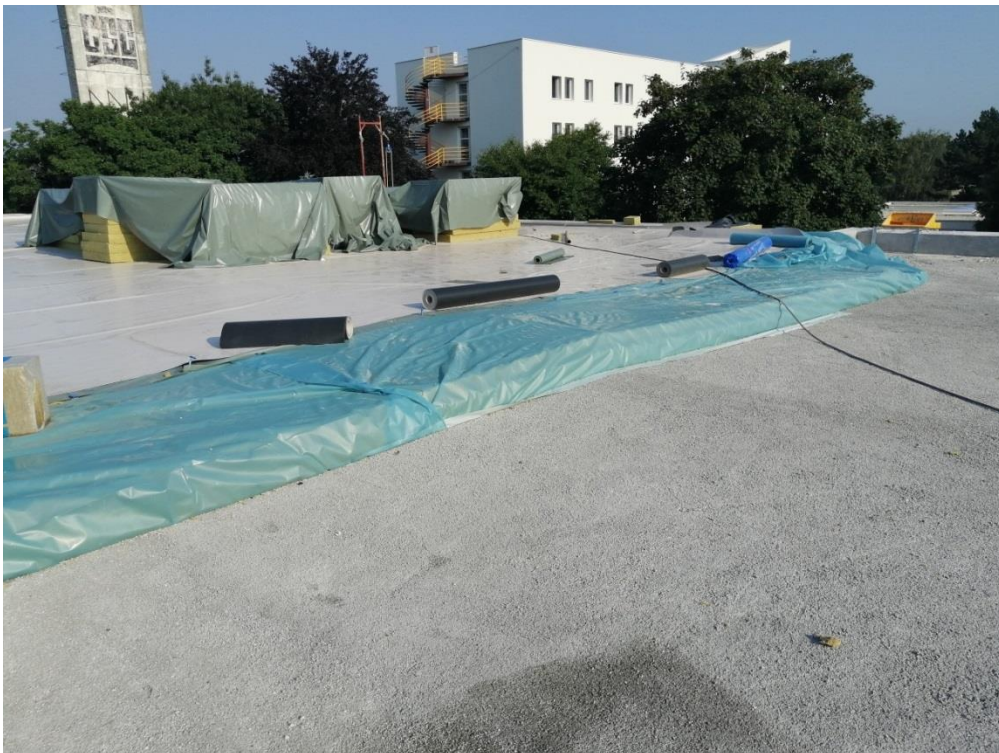
Slika 24. Izvođenje završnog sloja krova od TPO folije [10]
