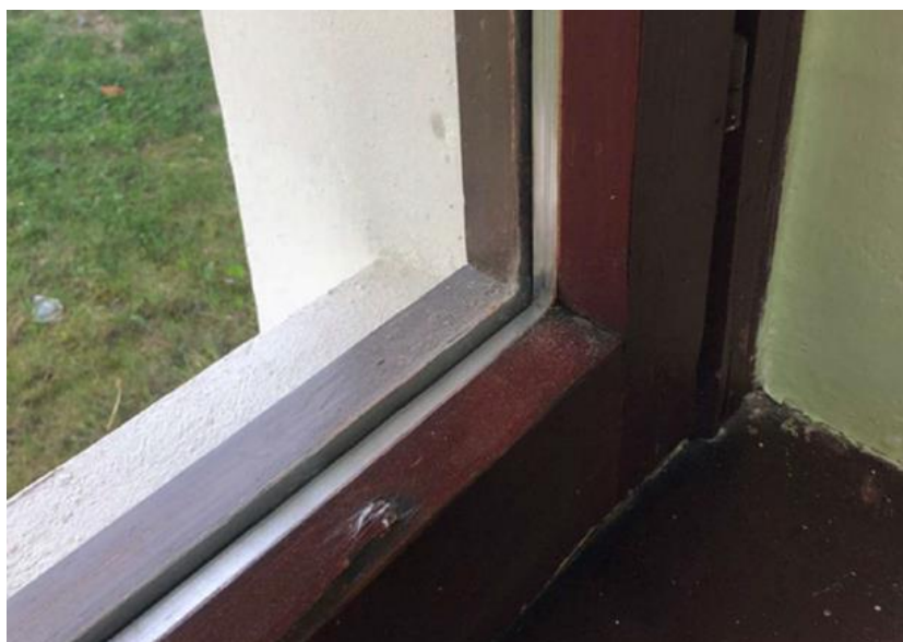
Slika 14. Detaljni prikaz postojeće stolarije [8]
