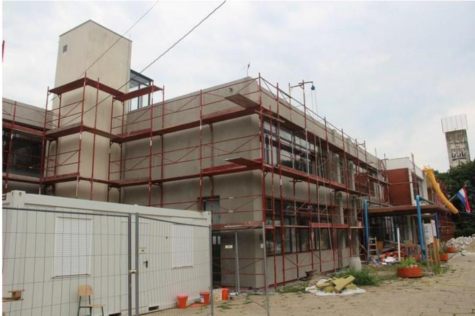
Slika 20. Implementacija polimer-cementnog ljepila armiranog tekstilno-staklenom mrežicom
