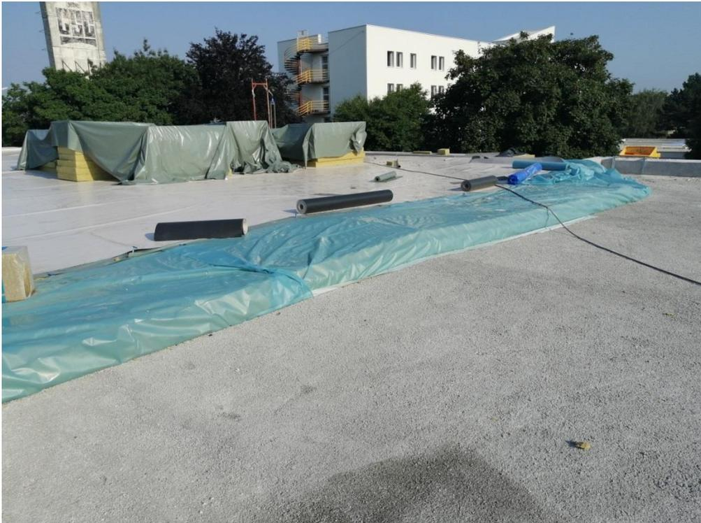
Slika 24. Izvođenje završnog sloja krova od TPO folije [10]
