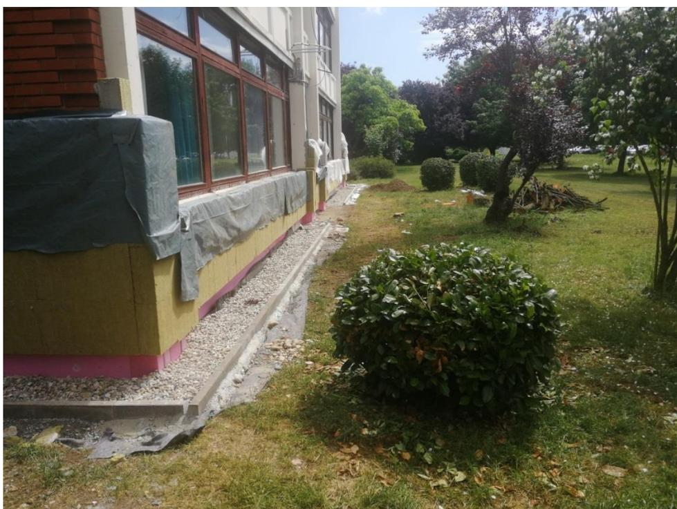
Slika 19. Izvedba toplinske izolacije pročelja
