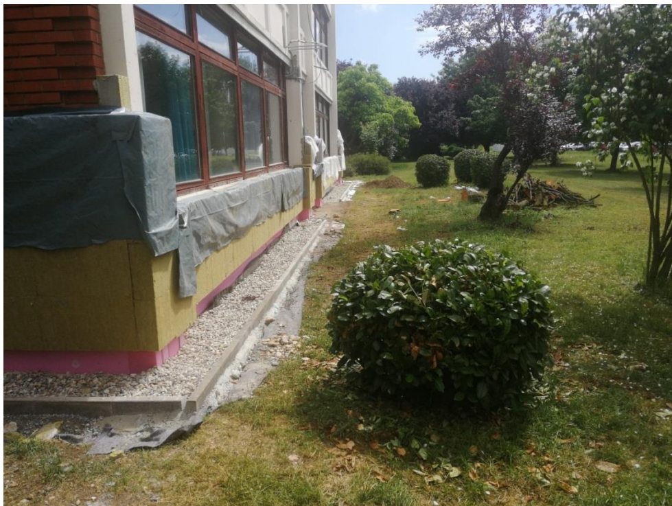
Slika 18. Toplinska izolacija južnog pročelja
