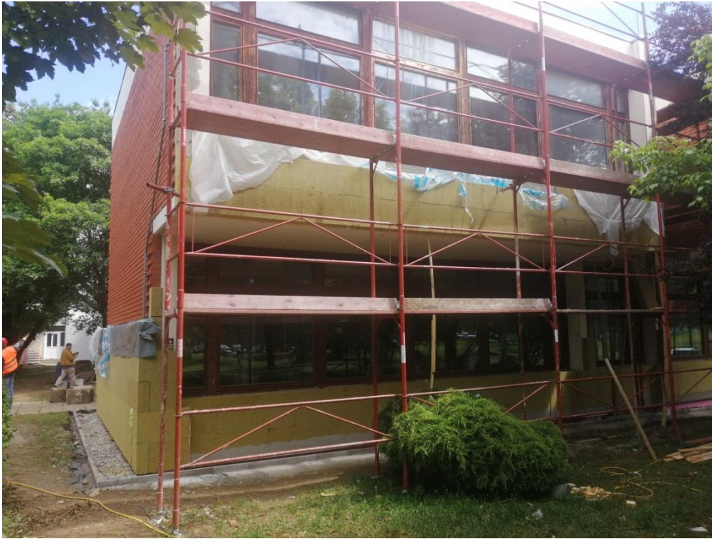
Slika 18. Toplinska izolacija južnog pročelja
