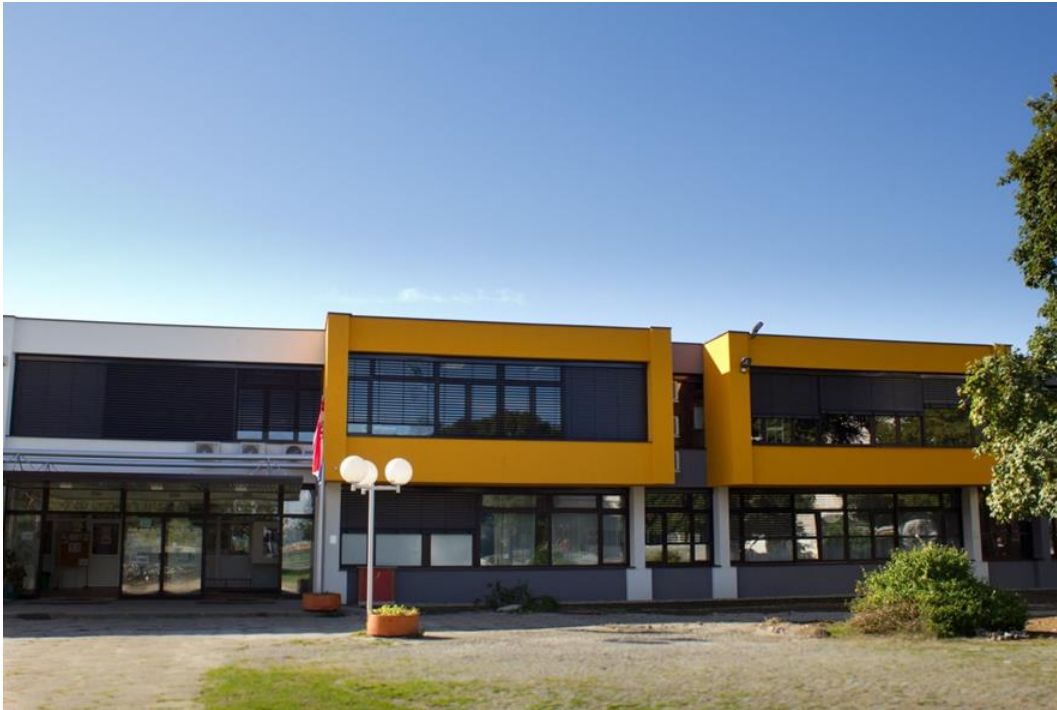
Slika 29. Sjeverno pročelje škole nakon energetske obnove [11]
