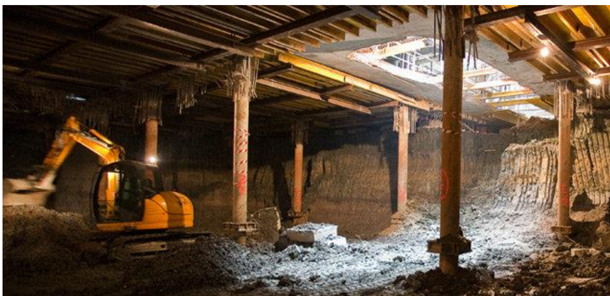
Slika 2.11. Izvedba podzemne garaže top-down metodom , „Cvjetni trg“, Zagreb.
