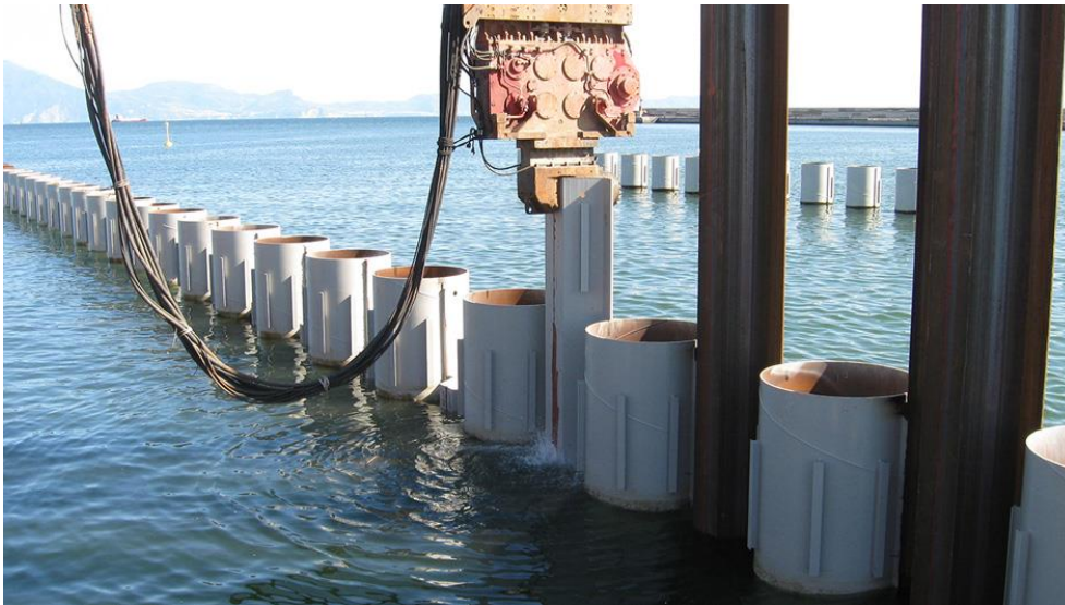
Slika 2.8. Čelijasti zagat.
