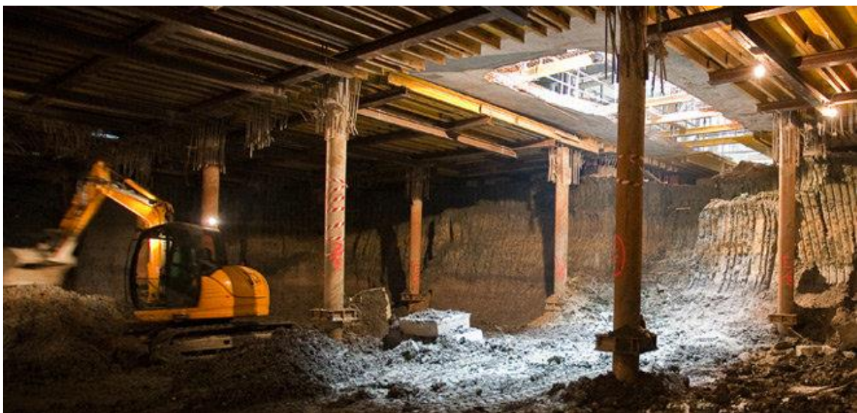
Slika 2.11. Izvedba podzemne garaže top-down metodom , „Cvjetni trg“, Zagreb.
