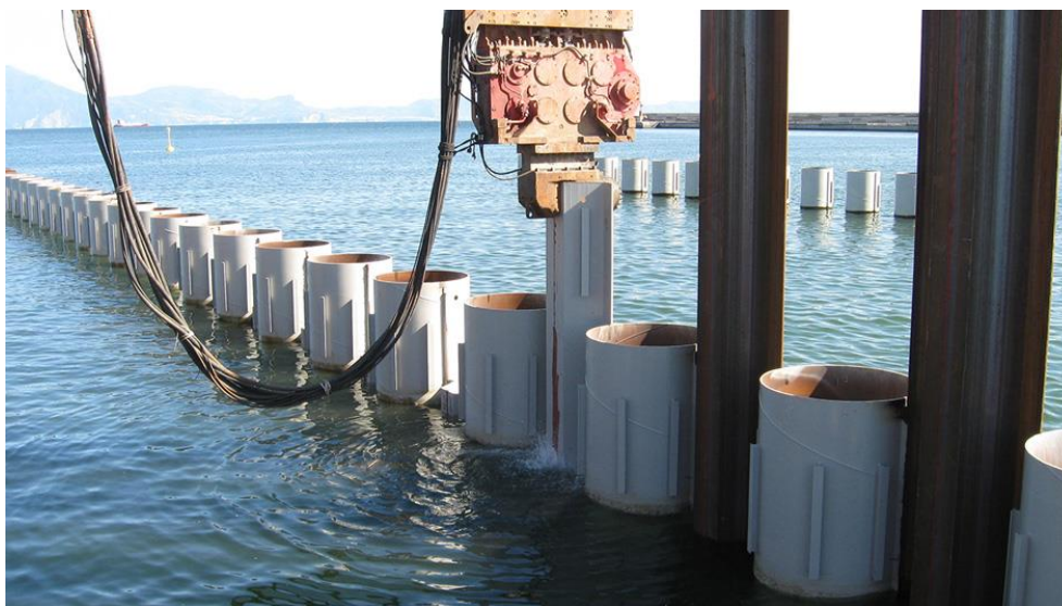
Slika 2.8. Čelijasti zagat.
