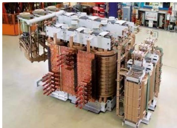
Slika 5. Korištenje bakra kod namotaja transformatora
