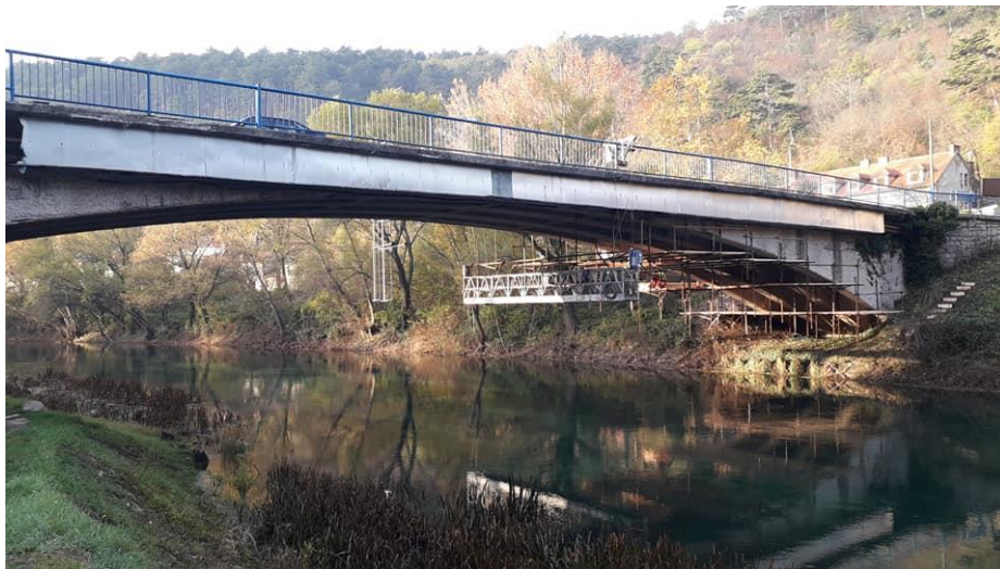
Slika 7. Rekonstrukcija mosta Atlagić u Kninu [28]
