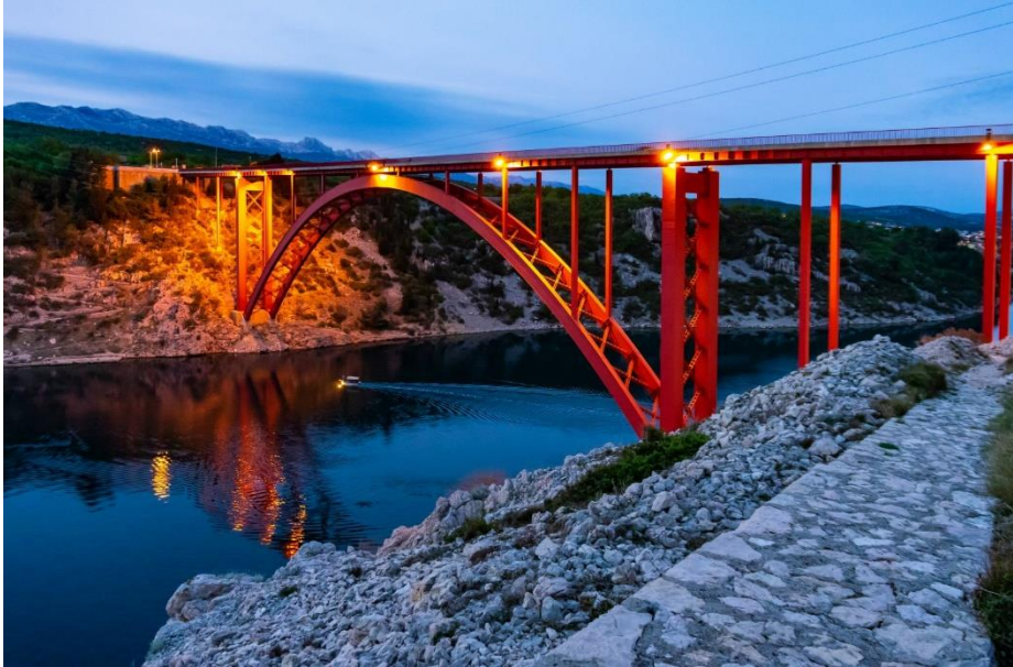
Slika 2. Primjer lučnog mosta - Maslenički most [27]
