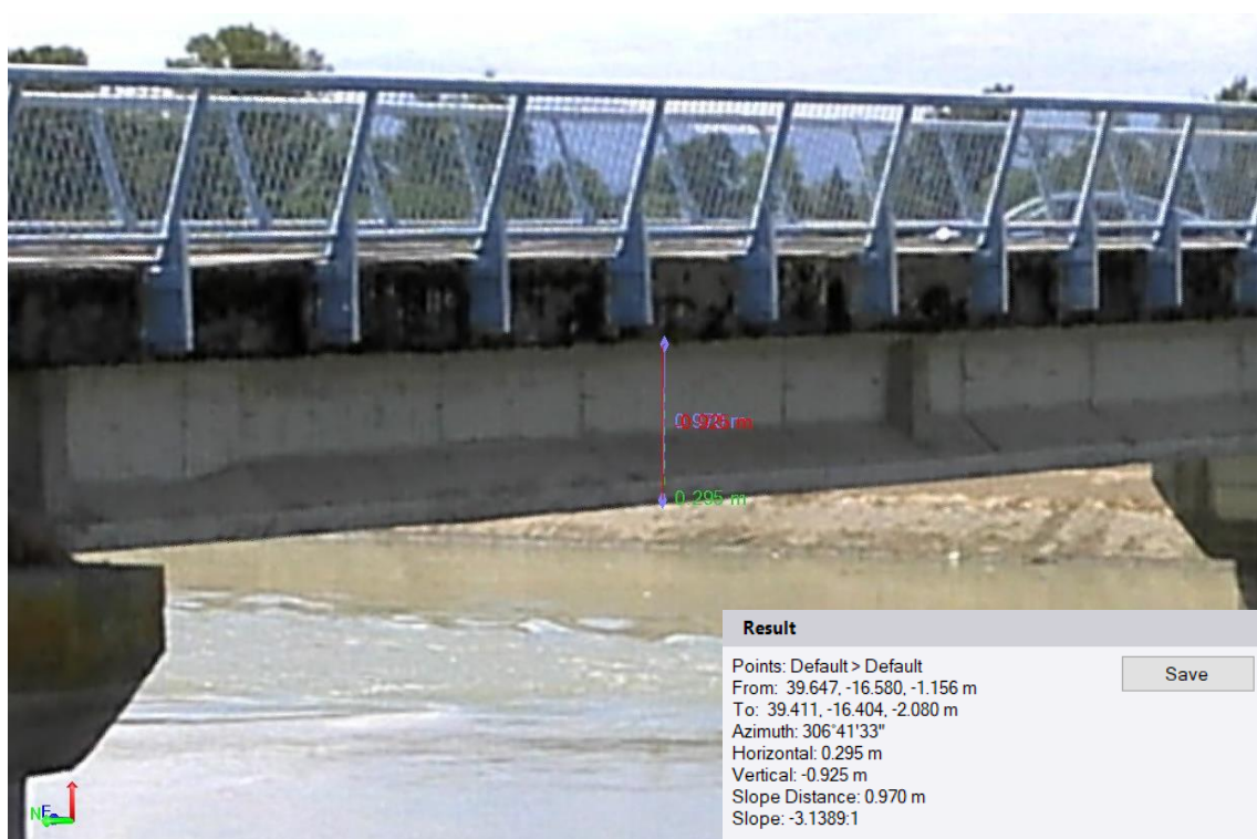
Slika 30. Očitavanje dimenzija iz 3D modela
