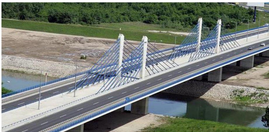
Slika 3. Primjer ovješnog mosta - Domovinski most u Zagrebu [26]
