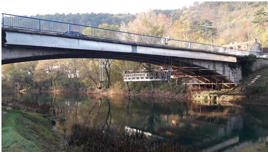
Slika 7. Rekonstrukcija mosta Atlagić u Kninu [28]
