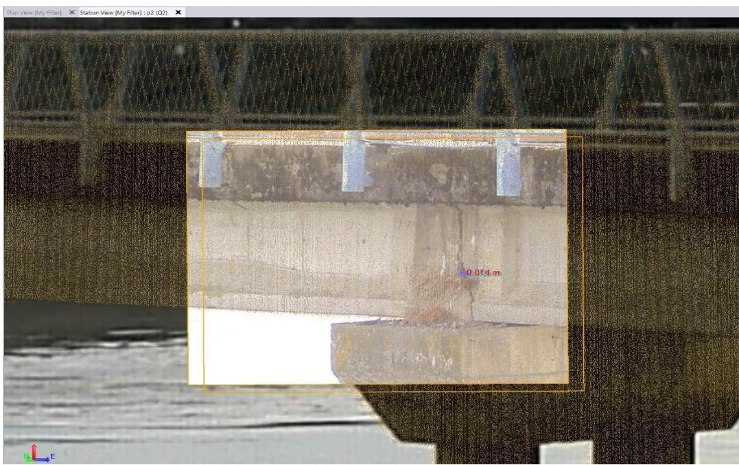
Slika 22. Mjerenje oštećenja mosta sa stajališta 2
