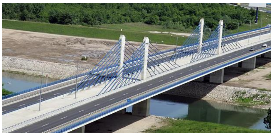
Slika 3. Primjer ovješnog mosta - Domovinski most u Zagrebu [26]
