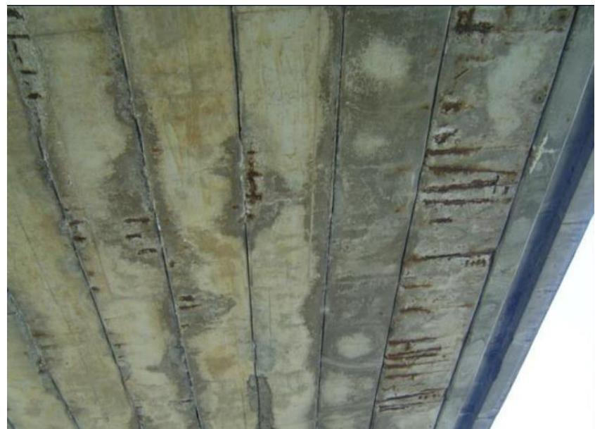
Slika 5. Primjer pogleda na rasponsku konstrukciju - vidljivi tragovi korozije [20]
