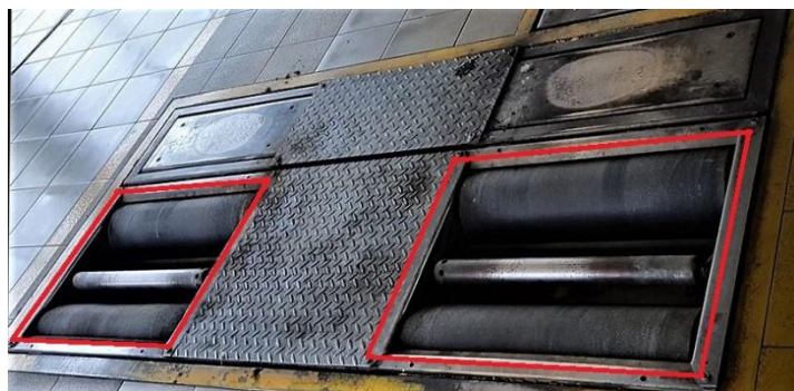
Slika 39. Valjci za mjerenje kočne sile (fotografirano 10.06.2021.)
