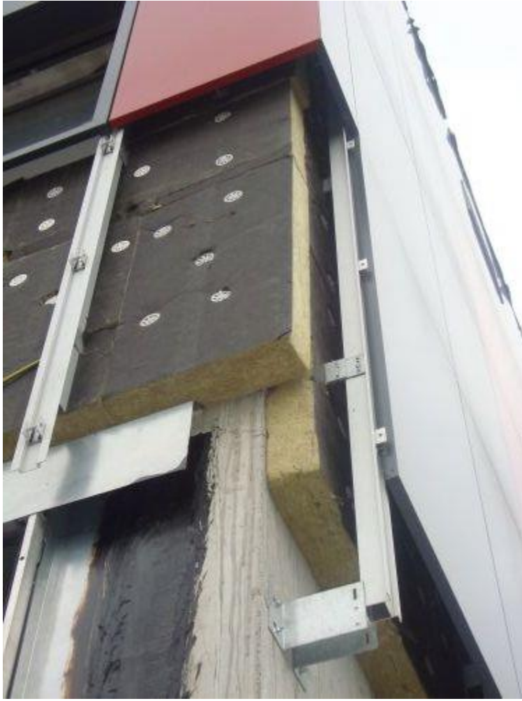
Slika 8.1. Slojevi ventilirane fasade
