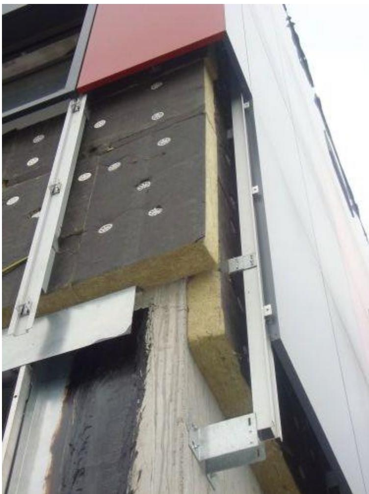
Slika 8.1. Slojevi ventilirane fasade
