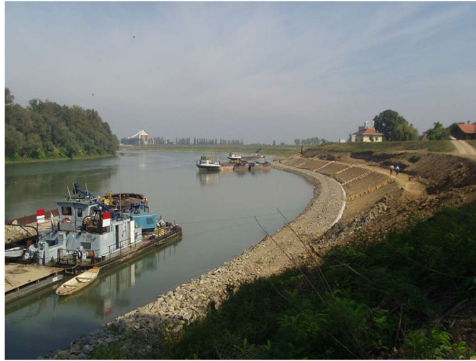
Slika 3.17 Kosa obaloutvrda s oblogom od lomljenog kamena [7]
