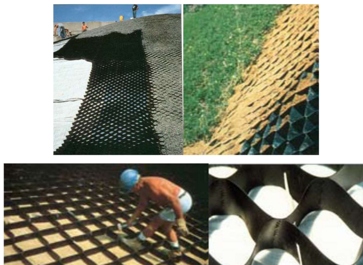
Slika 3.21 Kose obaloutvrde s oblogom od sintetskih materijala ispunjenih zemljom [7]
