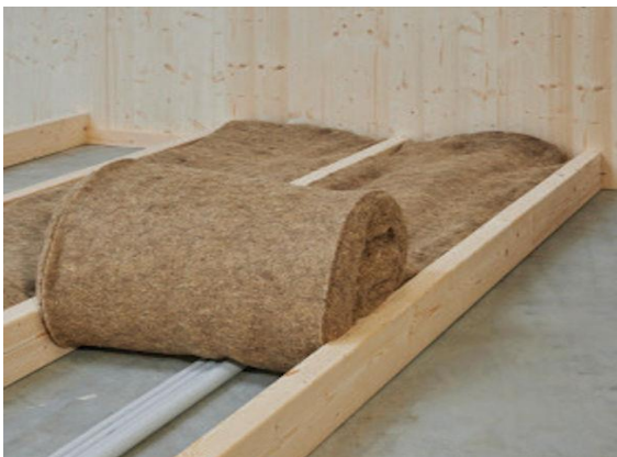
Slika 3.5.3 Izoliranje ovčjom vunom [20]
