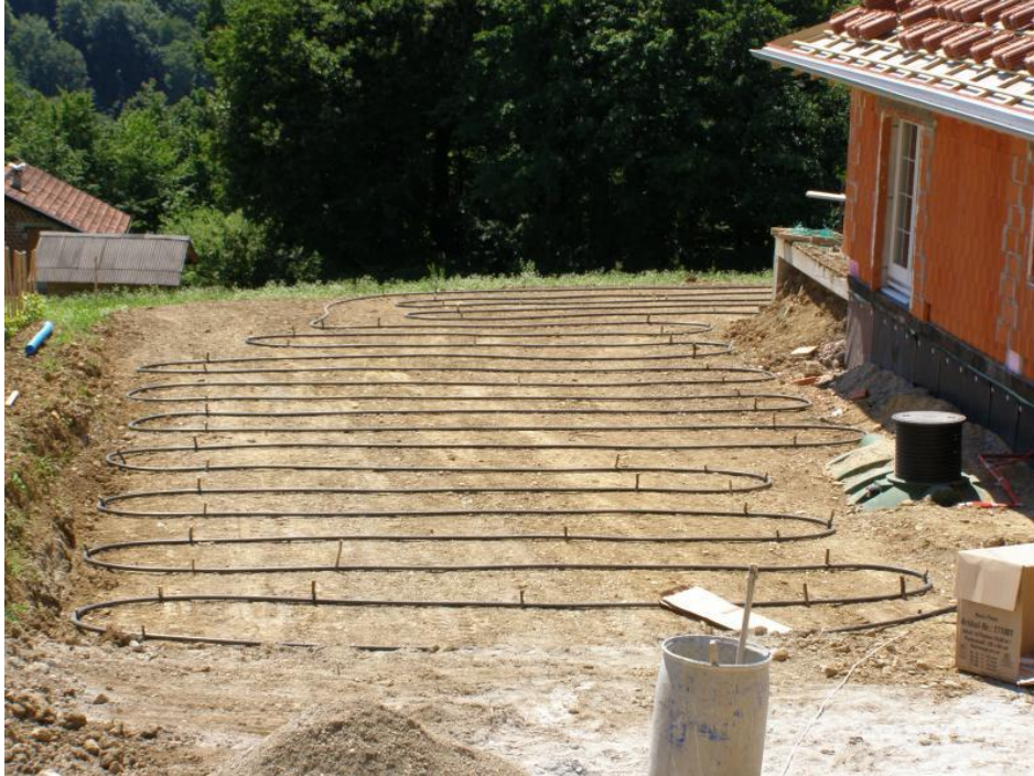
Slika 7.2.1 Prikaz dobivanje topline od površinske zemlje [37]
