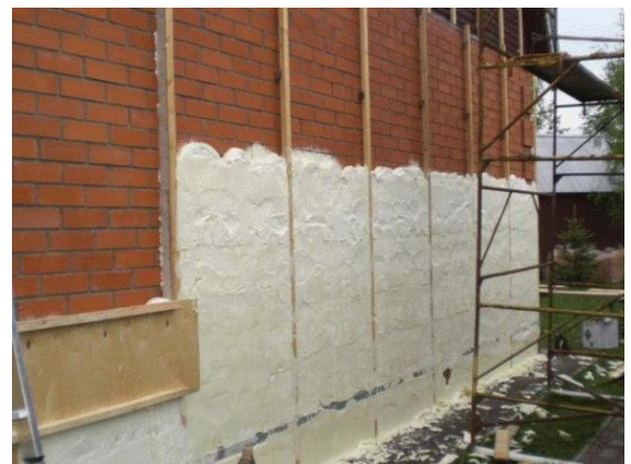
Slika 3.5.2 Izoliranje poliuretanskom pjenom [19]
