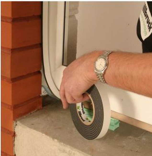
Slika 5.4.1 Brtvljenje prozora ekspanzivnom trakom radi zrakonepropusnosti [33]
