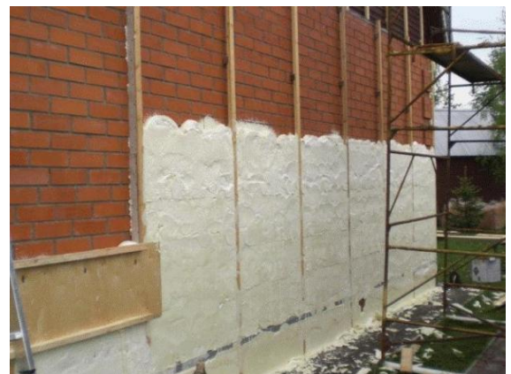
Slika 3.5.2 Izoliranje poliuretanskom pjenom [19]
