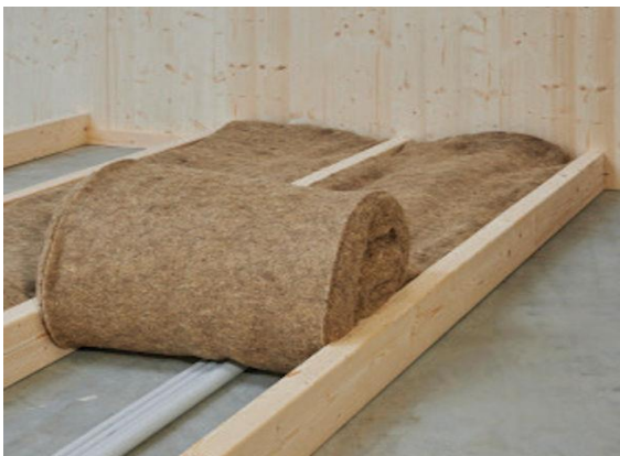
Slika 3.5.3 Izoliranje ovčjom vunom [20]
