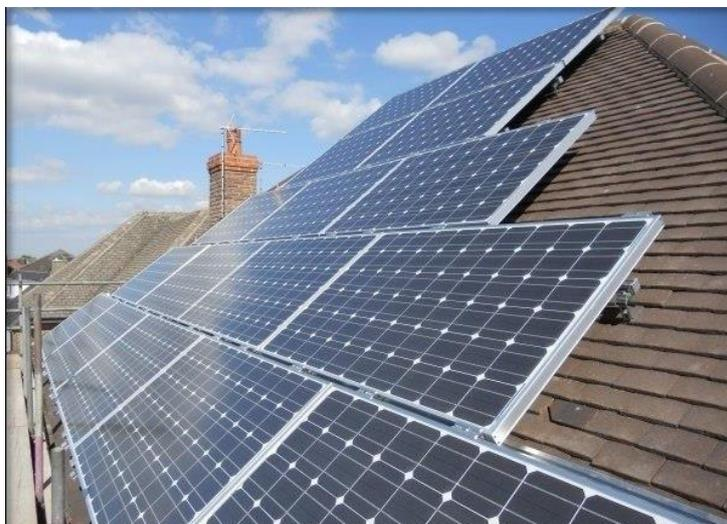
Slika 7.3.2.2 Izgled fotonaponskih pretvornika [43]
