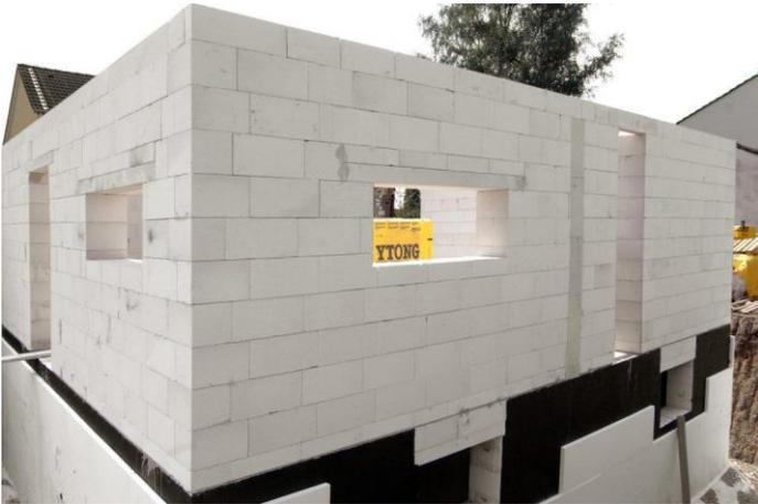
Slika 3.6.1.1 Prikaz gradnje porobetonom [26]
